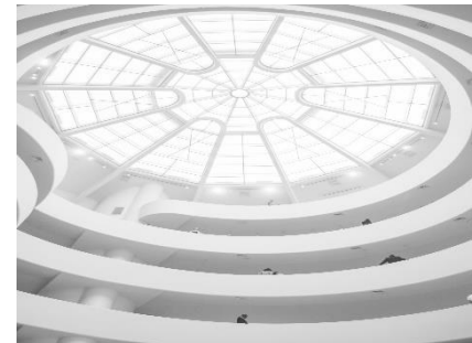
Figure :II-37: type d'éclairage par dôme .Source : https://c.pxhere.com/
