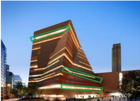
Figure :II-64 : façade d'extension Source : https://www.dezeen.com/
