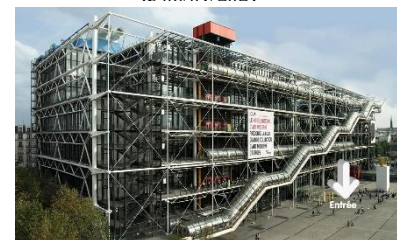
Figure :I-16 centre Pompidou Source : https://socioarchi.wordpress.com/ consulté le 06/01/2021
