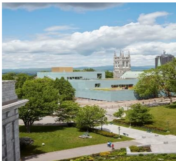
Figure :II-80 : la vue sur la galerie Source : https://www.architectura.be
