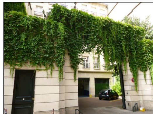
Figure I. 45: mur végétal extérieur avec des plantes retombantes.
