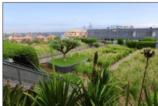
Figure I. 35: toiture végétalisée de type intensive Source : https://derbigum.be/blog (28/01/2021- 19:02)
