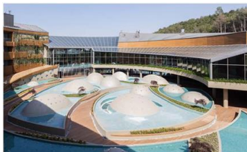
Figure II-39 : des photos aériennes représentent les terrasses et la piscine extérieure
