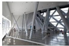
L'utilisation des pilotis et une structure métallique apparente
