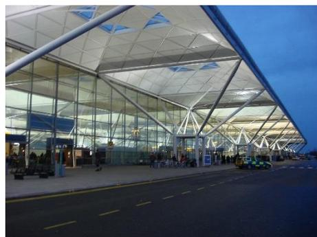
Fig18 : Les « arbres » portiques sont une extension de la structure intérieure.
