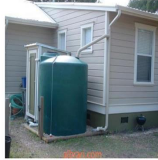
الصورة (2-1) : خزان بلاستيكي لتجميع مياه الأمطار من سقف المنزل. المصدر: باتر محمد على وردم. (2003) الصورة (3-1) : خزان اسمنتي لتجميع مياه الأمطار من سقف المنازل مغروس تحت الأرض المصدر: باتر محمد على وردم. (2003)
