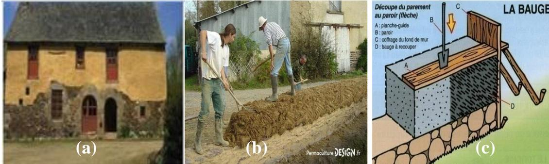
Figure 1-7 (a) Construction en bauge, (b) Mise en œuvre, (c) Principe de la bauge (Delbecque, 2011).
