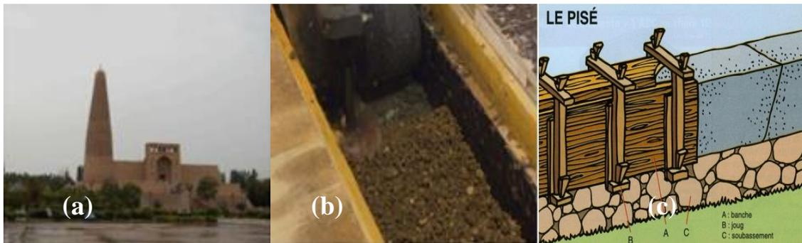
**Figure 1-9** (a) Mosquée en pisé édifée en 1788, (b) Compactage d'un mur en pisé, (c) Principe de pisé (Delbecque, 2011 ; Bruno, 2005).
