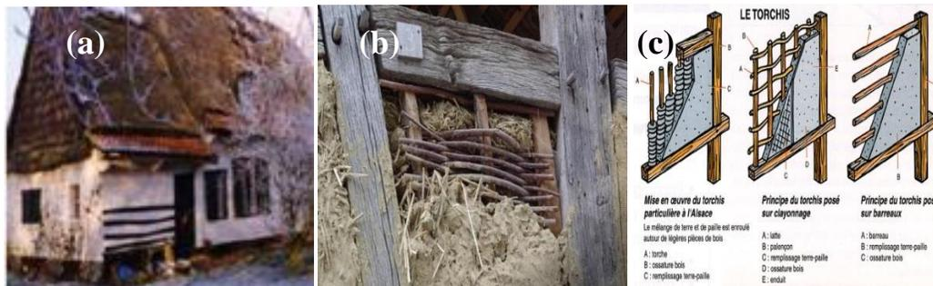
**Figure 1-8** (a) Construction en torchis, (b) Mur en torchis en cours, (c) Principe de la réalisation de torchis (Delbecq, 2011 ; Bruno, 2005).
