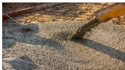
Figure I.2: coulage du béton
