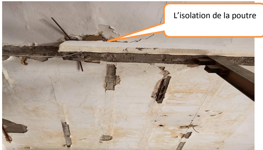
Photo 2.22 : l'isolation de la poutre (pas d'encastrement)
