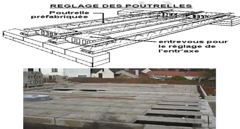
Figure 2.25 Mise en œuvre des planchers avec poutrelles préfabriquées
