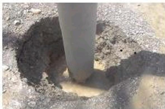
Figure II.21 : l'enfoncement du vibreur (22)
