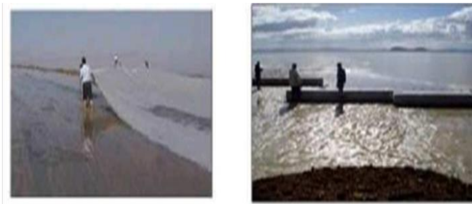
Figure II.5: pose des géotextiles de séparation (12)
