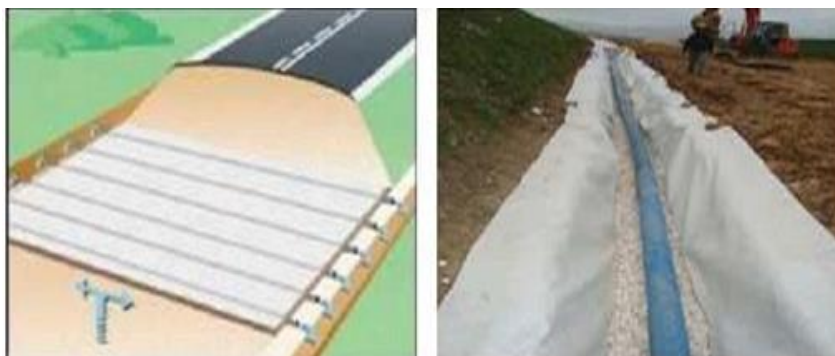
Figure II.9 : utilisation des géotextiles pour drainage (12)
