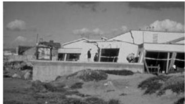
Figure 1.9 : Epanchage latéral le long de la route Sandholdt (à gauche) et destruction d'un centre de recherche (à droite) à Moss Landing[15]
