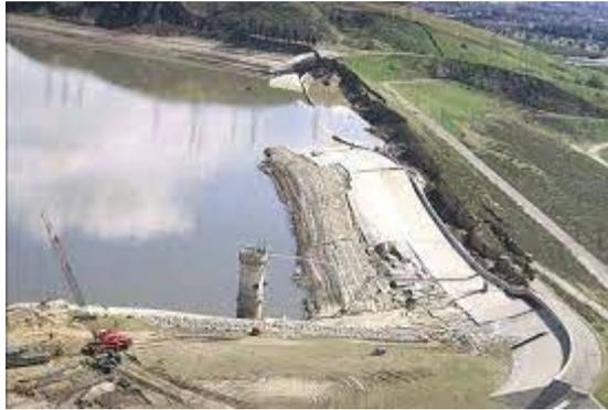
Figure 1.8 : Rupture de barrage (San Fernando 1971)[15]
