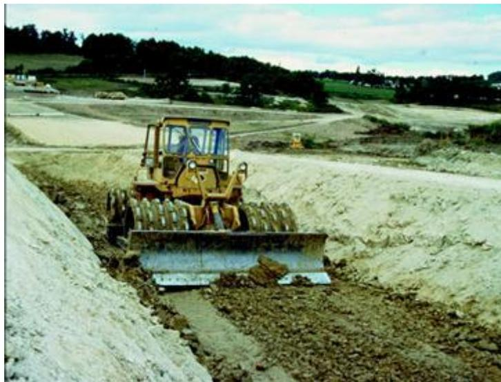
Figure 2.6: Compactage d'argile dans la clé d'étanchéité.
