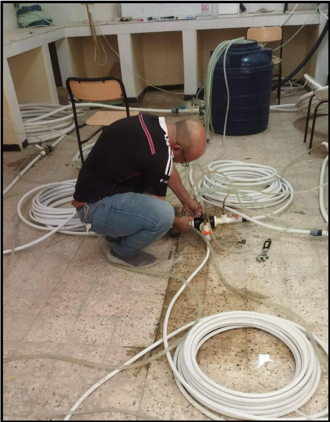
*Figure IV.5 : l'installation d'une prise de débit dans le nœud 9.*
