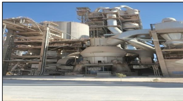
Figure I.13 : broyeur cru VRM
