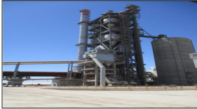
Figure I.16: la tour de préchauffage
