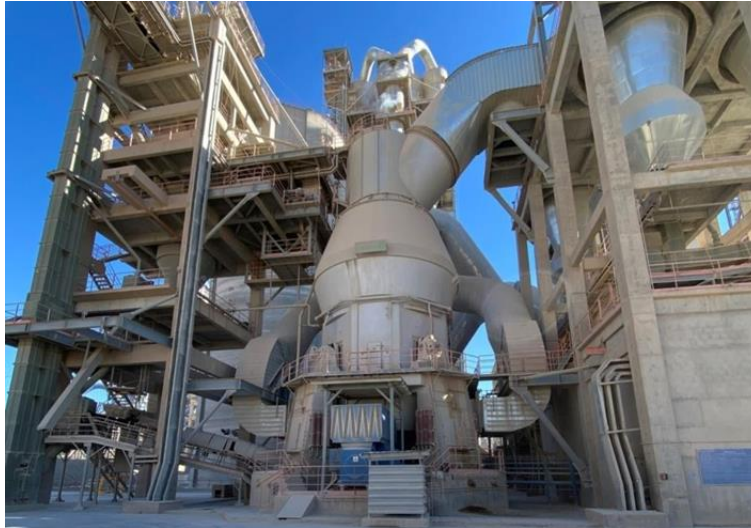
Figure 4 : Broyeur cru.
