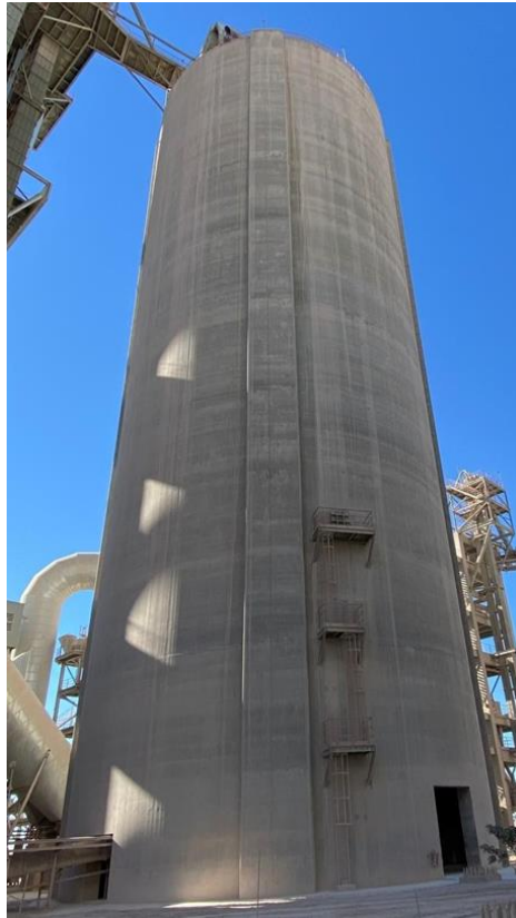
Figure 5 : Silo homogène de farine crue.
