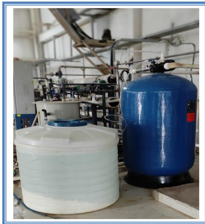
**Figure IV.3** : Adoucisseur utilisée à l'usine ENASEL El-Outaya
