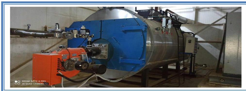
**Figure I.7 :** La chaudière MYRA 400 utilisée à l'usine ENASEL El-Outaya
