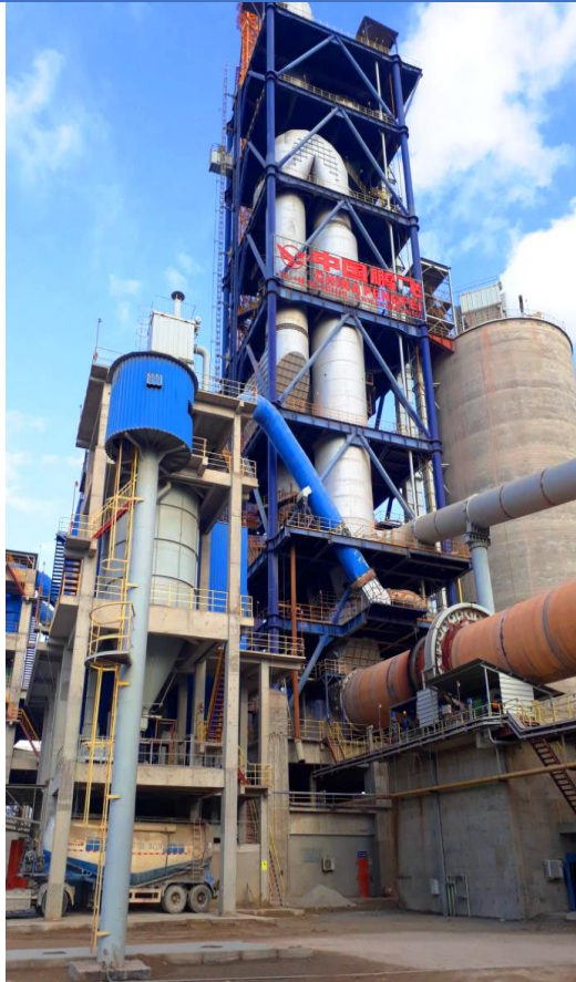
Figure I.20 La tour de préchauffage.
