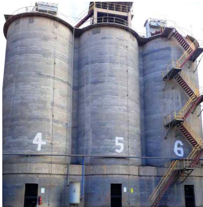
Figure I.27 : Silo de stockage de ciment
