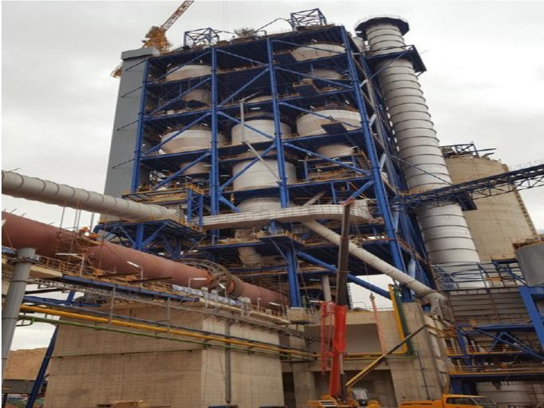
Figure 1.10 : Tour de préchauffage.
