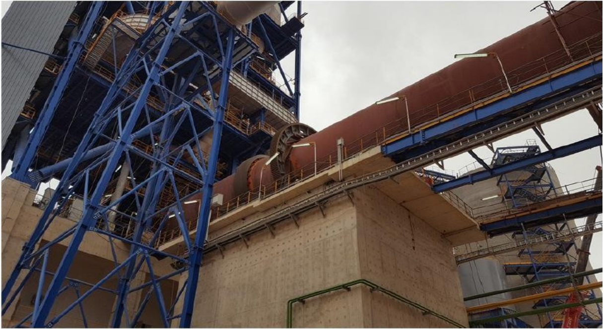
Figure 1.11 : Four rotatif.
