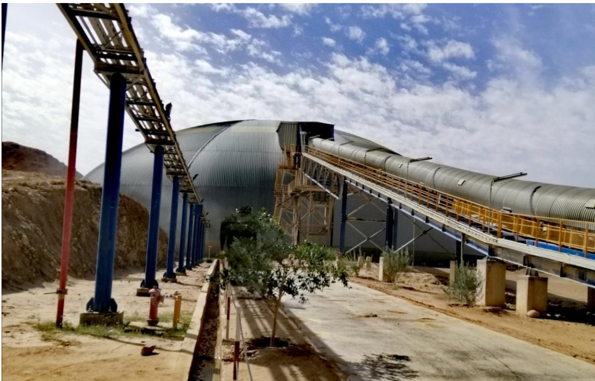
Figure 1.7: Hall de pré-homogénéisation.
