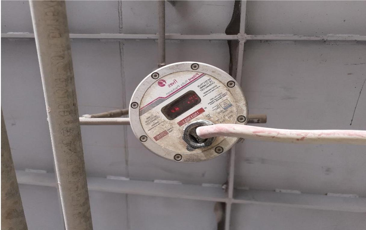
Figure III.7 : Contrôleur de flamme
