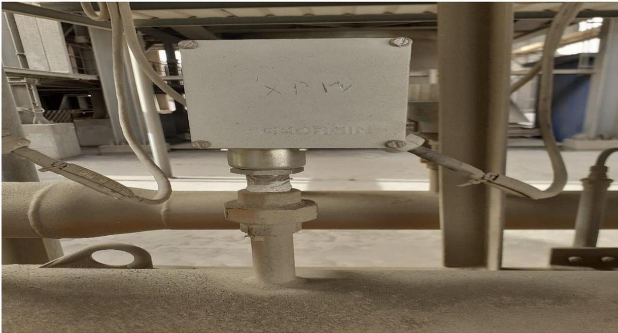
**Figure III. 3 : Pressostat**
