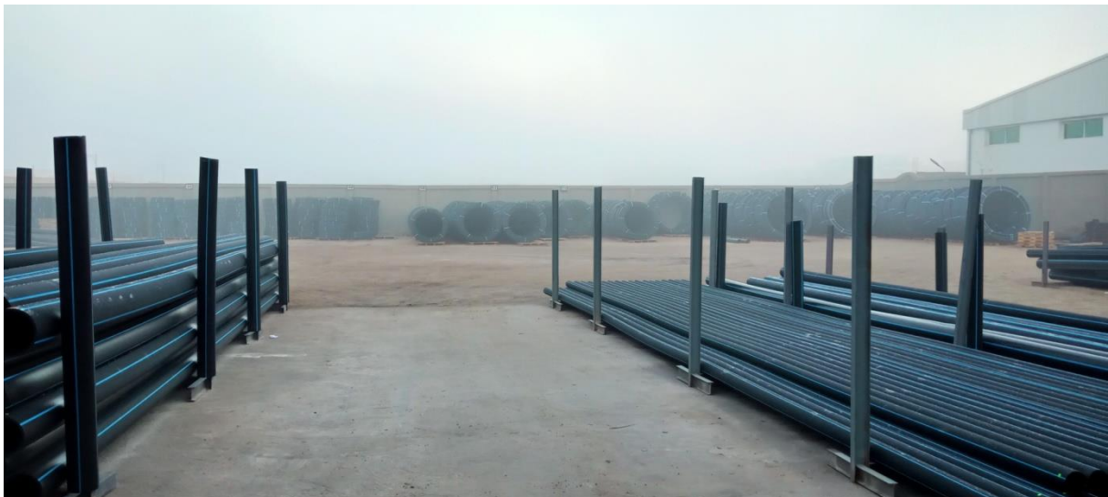
Figure 1. 2 Une photo de l'intérieur de l'usine
