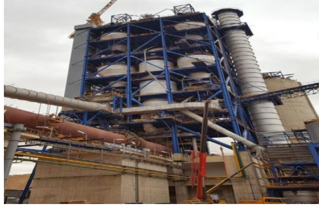
Figure II. 5 : Tour de préchauffage. [11]
