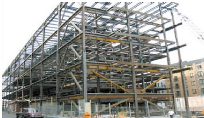
**FigureII.1 : Un modèle Structure métallique en phase de montage pour un bâtiment à étages**
