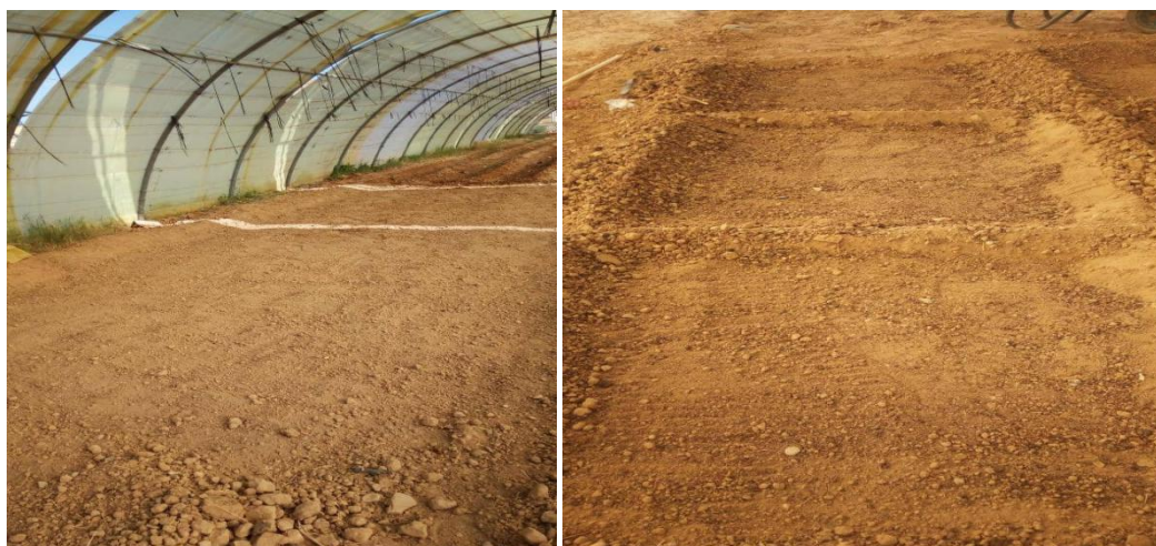
Photo05 : nivellement du sol
