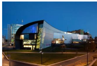
fig.17 expression du bâtiment (www.sfu.ca)
