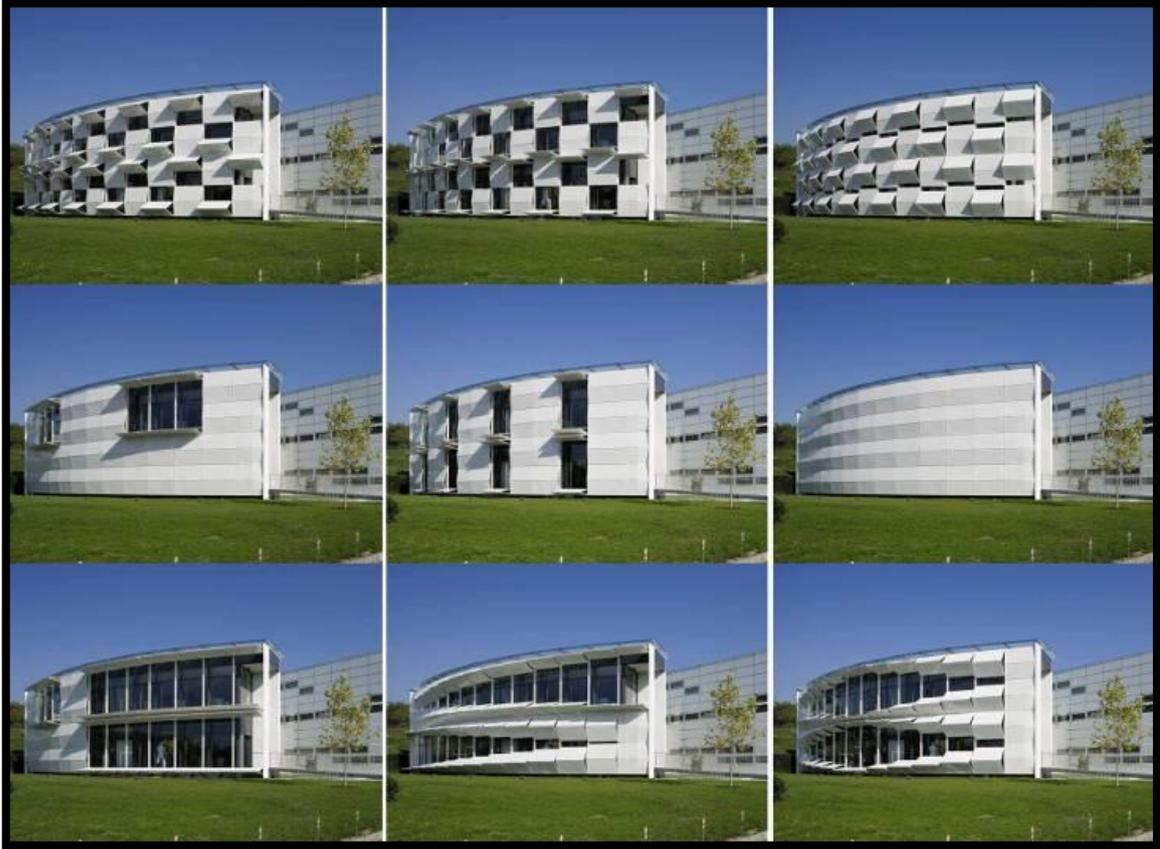
*Figure 5: Différentes configurations de la façade du bâtiment de Kieffer technique Showroom.*
