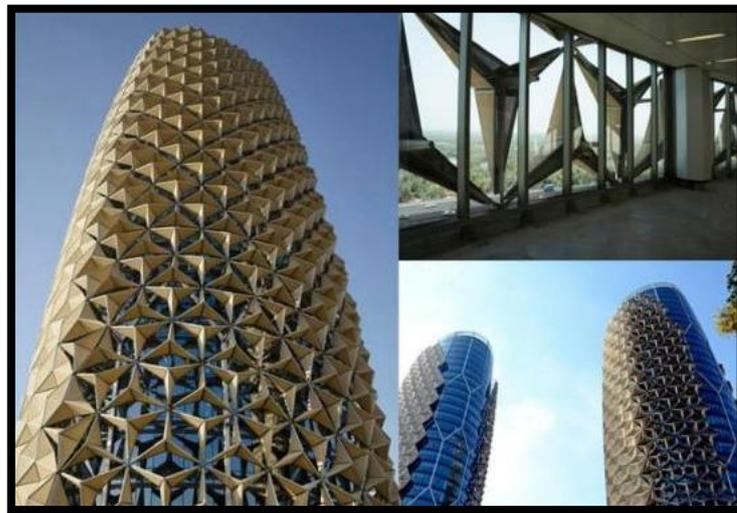
Figure 7: Al-Bahr Tower, à gauche la conception de façade dynamique, à droite vues sur le projet.
