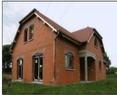
Figure I.06 : L'enveloppe en remplissage maçonné
