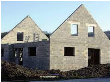
Figure19 : maison en maçonnerie source : fib.org.com
