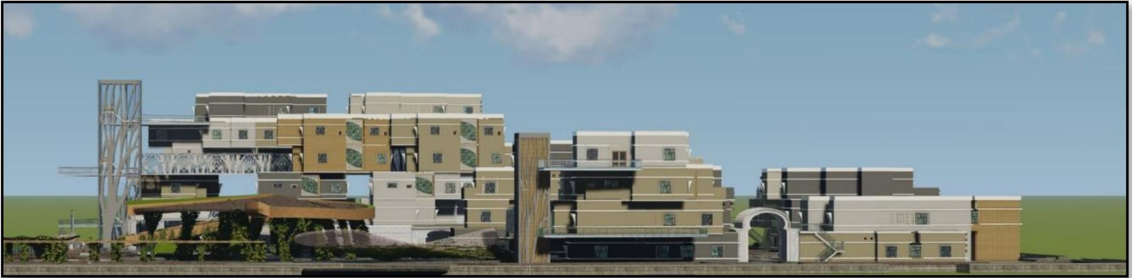
صورة 236: توضح الواجهة الغربية للمجمع السكني المصدر: الباحث 2019
