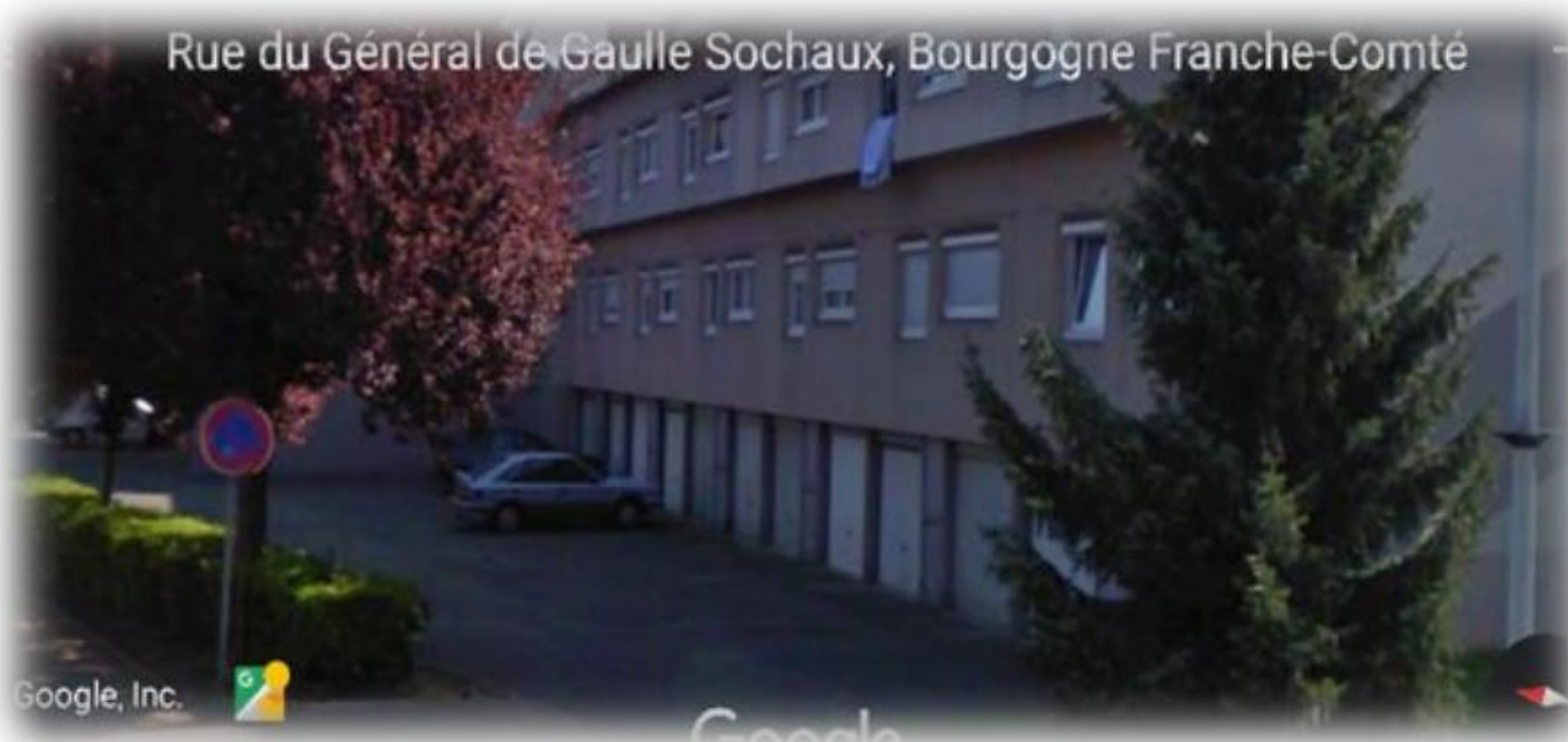
صورة 57: توضح مجال نصف عام المصدر: قوقل ارث
