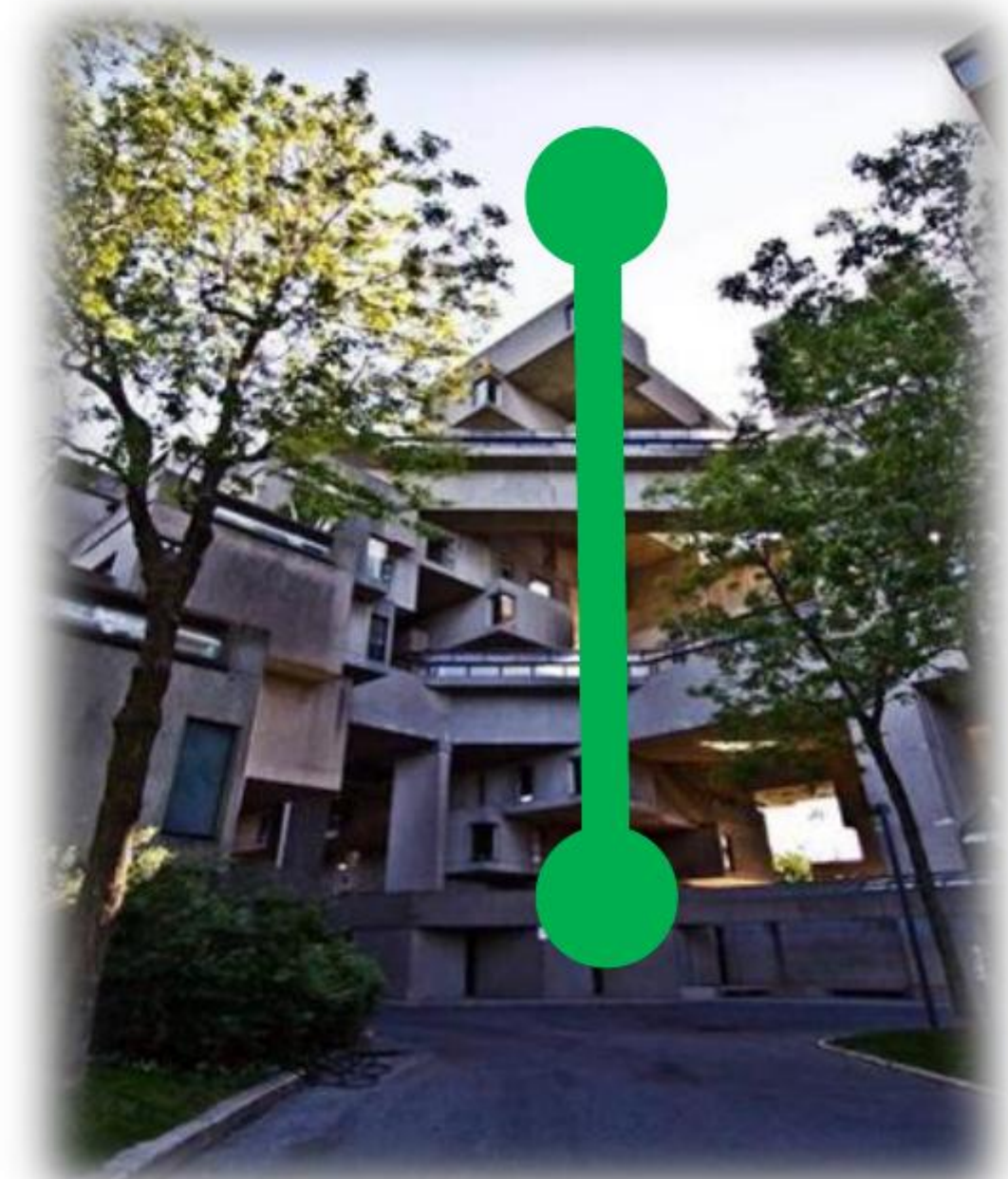
صورة 99: محور التجميع المصدر: قوقل ارث بتصريف الباحث 2019
