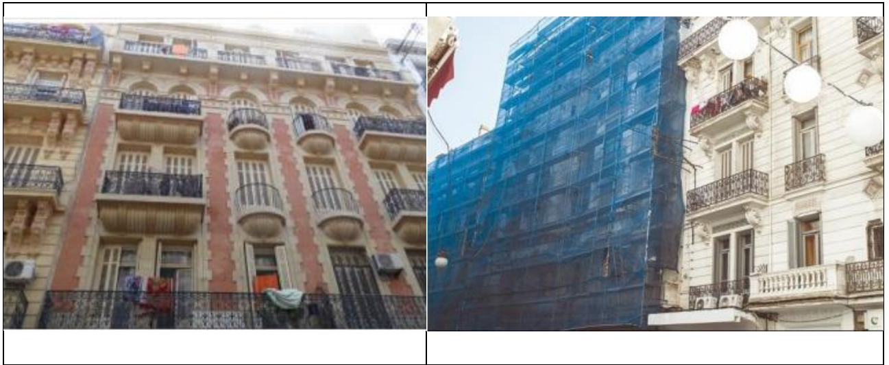
Figure 1.15 : exemples d'opération de réhabilitation dans plusieurs villes algériennes.
