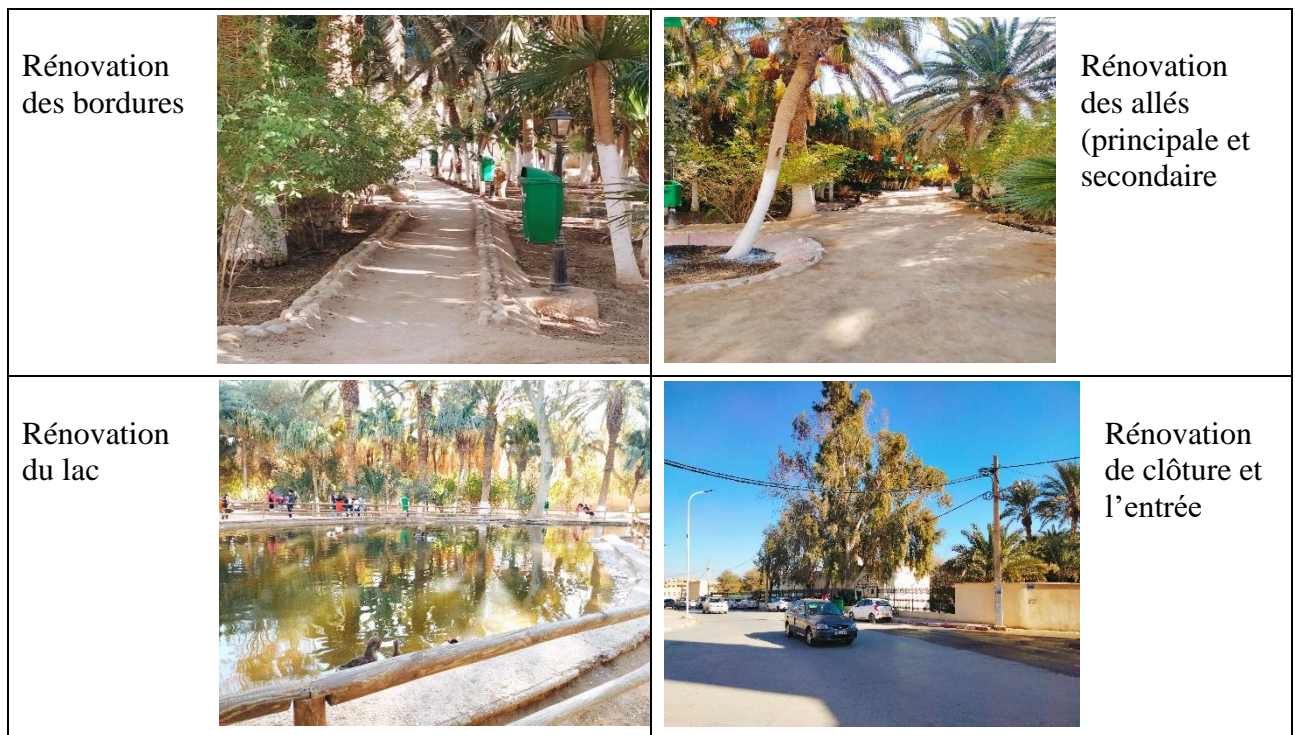
Photo 2.1 : les travaux de la réhabilitation du jardin Landon. Source : l'auteur 2022.
