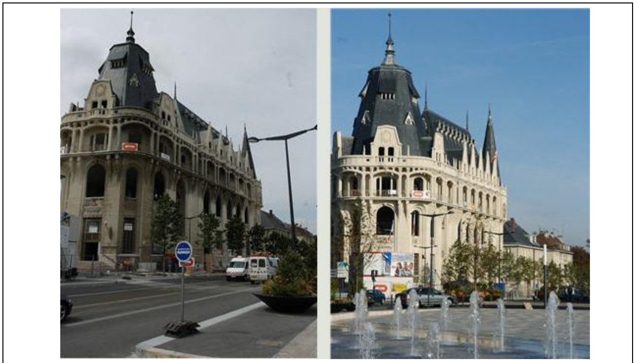
Figure 1.14 : exemples d'opération de rénovation (ancien hôtel du poste transformé en médiathèque).
