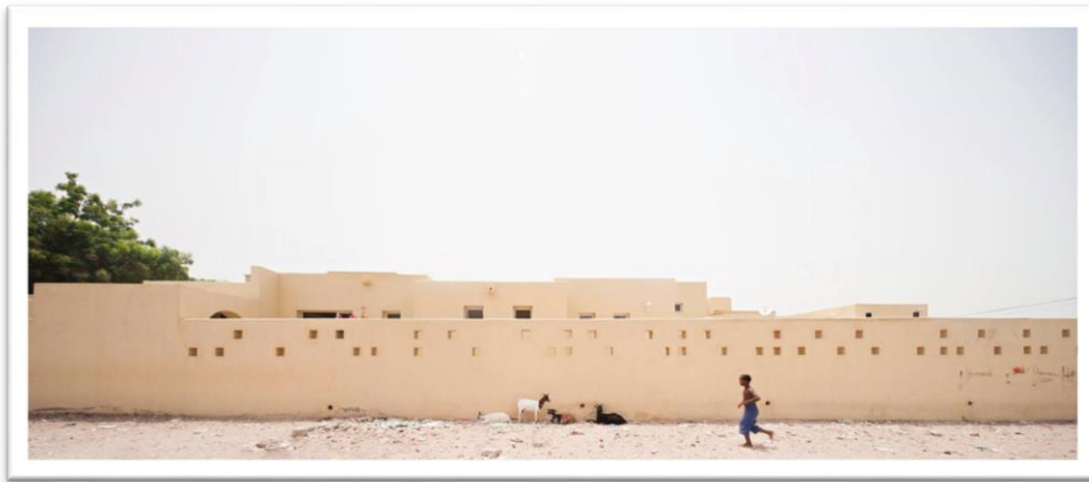
الصورة 10: معالجة الواجهات الخارجية
