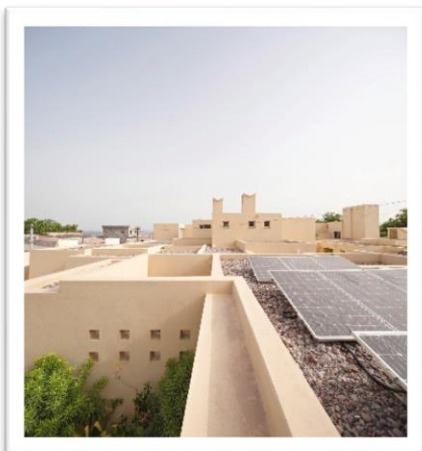
الصورة 9: عزل الأسطح
