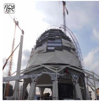
الشكل 83: الهيكل المعدنية للقبة
