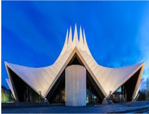
الشكل 17: هيكل سقف الألواح المطوية المصدر: www.prodyogi.com 06/04/2022
