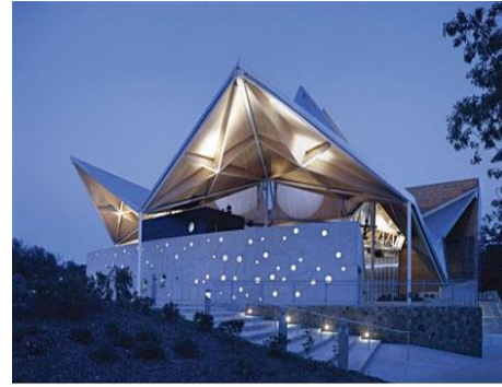
الشكل 18: شكل لهيكل سقف الألواح المطوية
