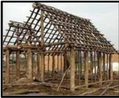
الشكل 05: هيكل منزل مصنوع من الخشب
