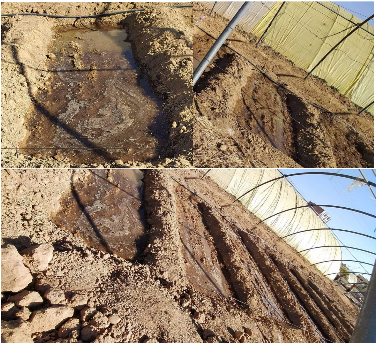
Figure 18 : Installer un système d'irrigation le début de décembre (original image).
