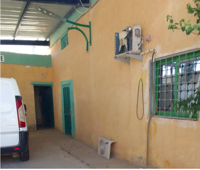
الشكل رقم (2-33): مخرج الطوارئ المصدر: إعداد الطالبة
