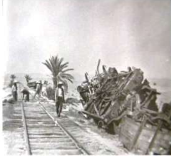
Dégâts matériels causés par les mines posées par le Moutjahid et Chahid Amor Amor (Allah yarhmou), au cours de la guerre de libération nationale. Photos prises sur le tronçon El Kantara-Aïn Souta de la ligne de chemin de fer Skikda-Touggourt.
