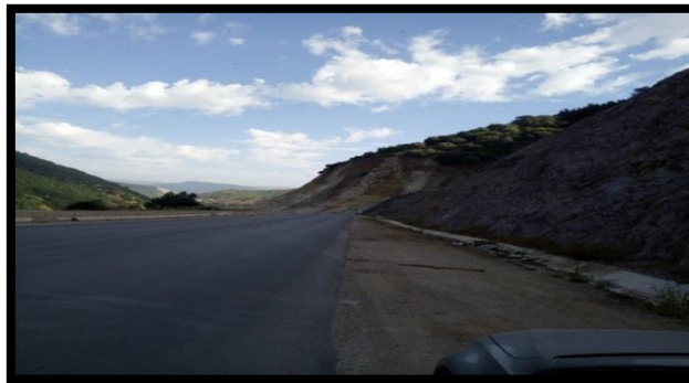
Fig. N° 74. La rocade Nord, mais qui est juste élargie à droite vu le terrain rocheux de djebel Aït Aïssa Mimoun, et à gauche c'est un ravin qui donne sur le Sebaou, mais après, la rocade aura ses six voies (06) comme la Sud.
