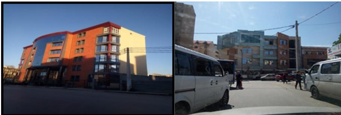
Fig. N° 135. Nouveaux sièges de la DLEP à gauche, en haut à droite au fond un nouveau lycée construit dans le premier axe principal « Amyoud » de la grande centralité avec des façades en panneaux. Cette Typologie est devenue à la « mode » pour le traitement des façades à Tizi-Ouzou.
