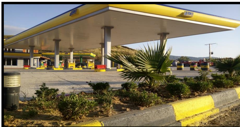
Fig. N° 77. La Nouvelle station Naftal sur la sortie de la Rocade Sud vers la RN 12 élargie.
