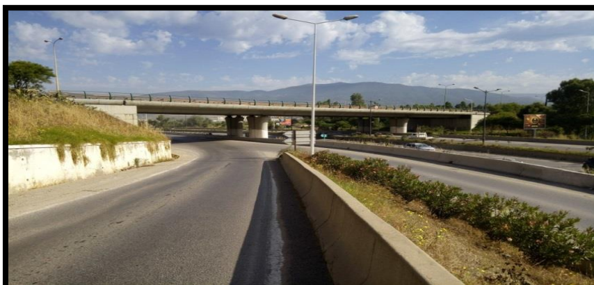
Fig. N° 75. Après les gorges du Sebaou, la rocade aura quatre voies. On constate, le passage du chemin de fer vers Oued Aïssi sur le pont.
