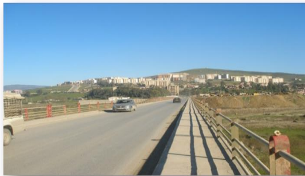
Fig. No 119. L'Entrée de la RN 12 élargie sur le pont en peigne vers Tamda en face.
