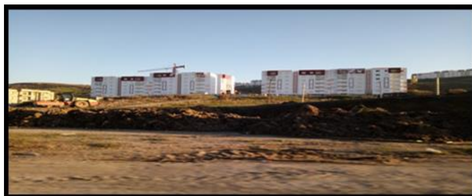
Fig. N° 128. Logements AADL à Oued Falli au-dessus du stade et ailleurs au fond,
