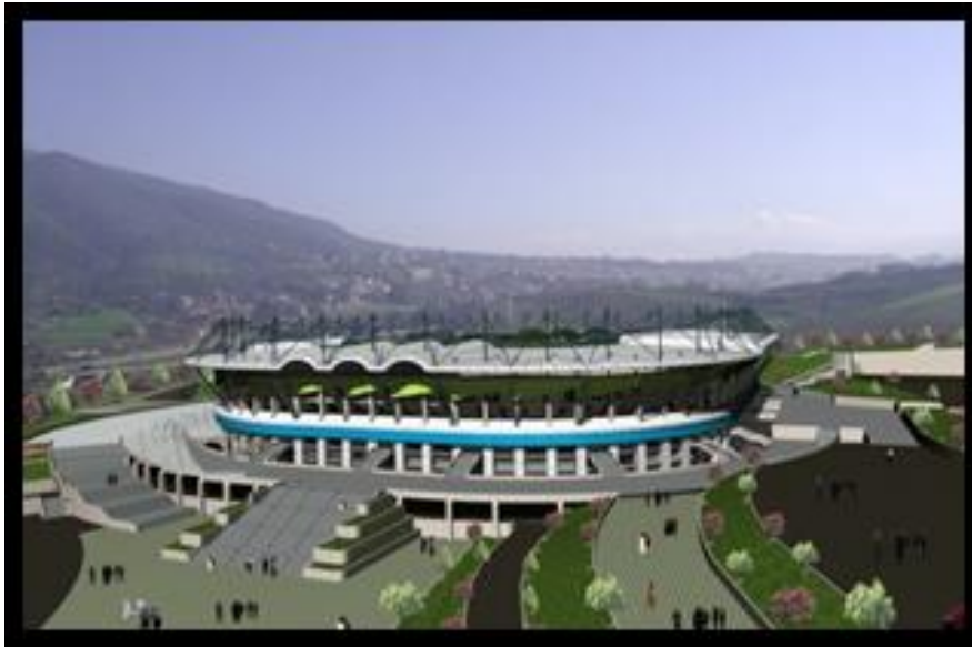
Fig. n° 129. Stade de 50 000 Places à Oued Falli en finalisation
