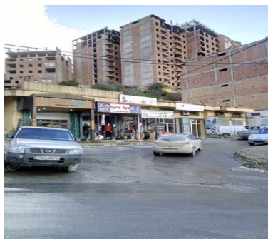
Fig. N° 142. Regarder aussi le nombre impressionnant de coopératives immobilières dans le lotissement el Bordj dans le grand Centre de Tizi-Ouzou., dont l'extérieur est aussi non fini (en voie la brique non crépis).
