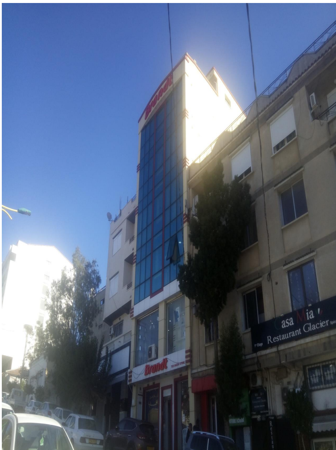
Fig. N° 138. L'utilisation de la marque de la chaine Américaine « Brandt », ici c'est le nouveau bâtiment (restructuration partielle du centre-ville) qui abrite le siège de celui qui possède l'exclusivité régionale situé au centre-ville.
