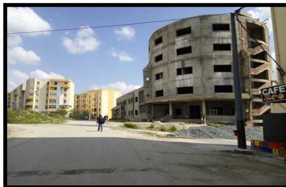
Fig. N° 121. La Polyclinique en voie de finition.
