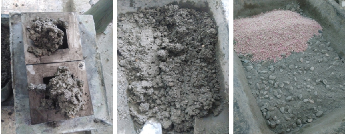
Figure 46. Mise en œuvre des bétons composites TESC-B
