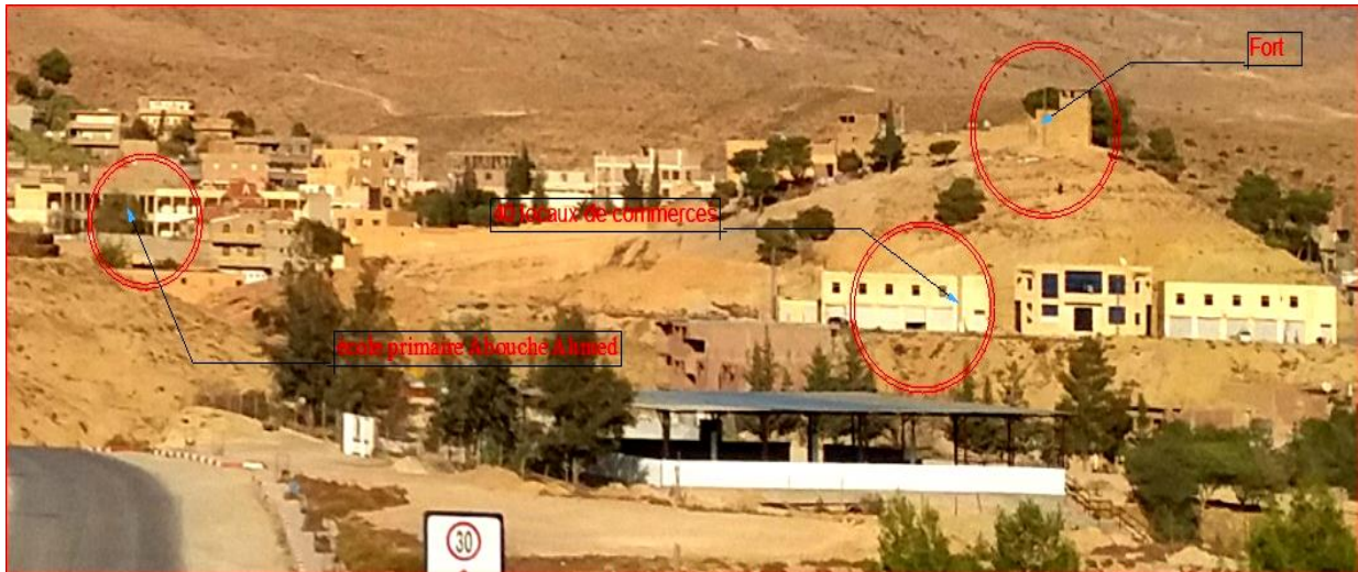
Figure V-29 : Différents équipements à Menâa. (Source : Auteur, 2018)
