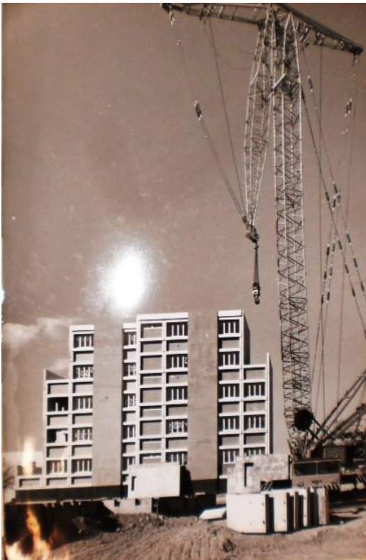
Figure V-95 : vue de chantier en réalisation D'un ensemble de logement collectif (Source : Patrice R, 1975).
