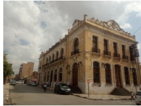
Figure V-105 : La modification d'aspect avec usage de matériaux modernes sans transformation du volume (Source : Auteur ,2019)
