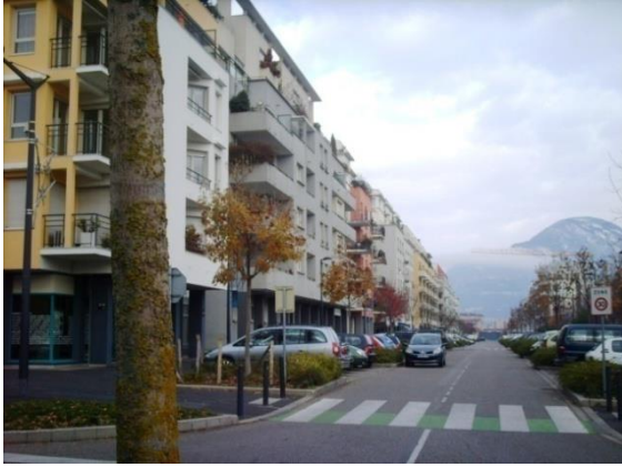
Figure II-18 : Habitat collectif a Grenoble (Source : Auteur, 26/11/2010 à 16 h.)
