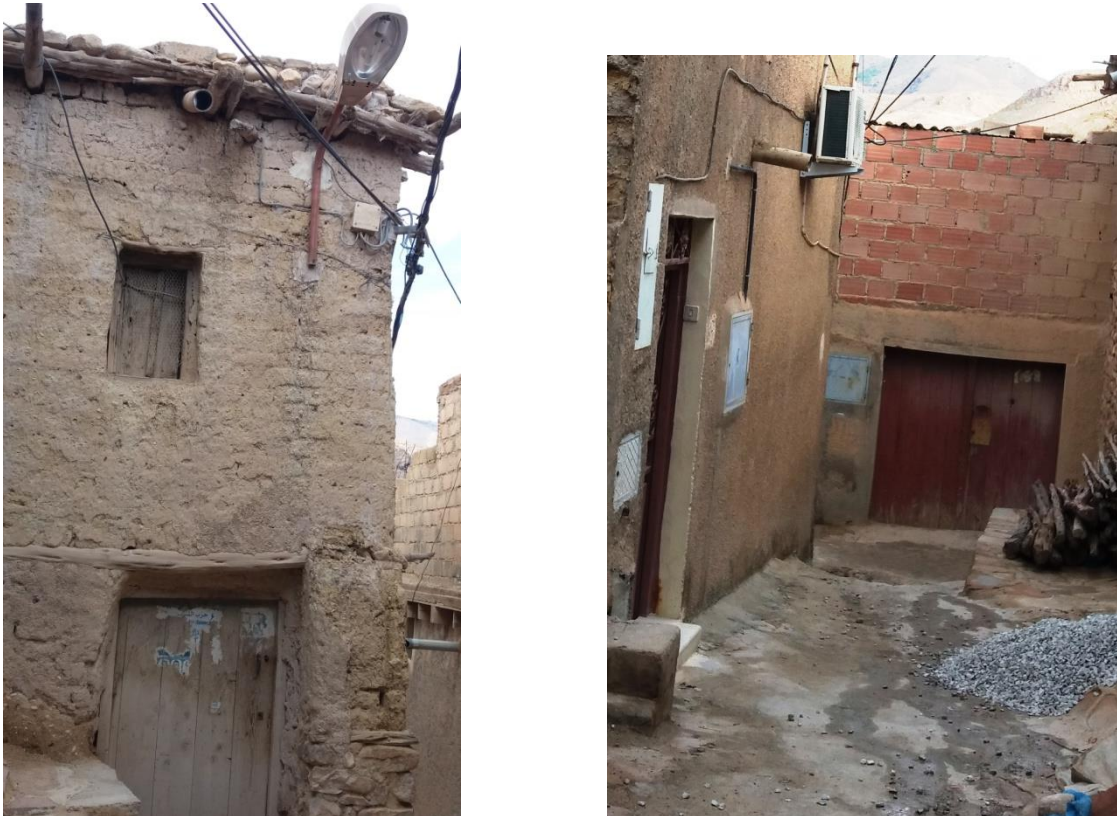
Figure V-7 : L'introduction de nouvelles techniques et infrastructures tels que l'assainissement, l'A.E.P,Gaz et l'éclairage public (Source : Auteur, 2016)
