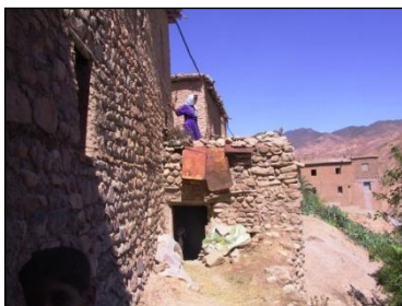
Figure VI-14 : vue d'extérieur de la maison (cas 01) dans le tissu traditionnel de Menâa (Source : Auteur, 2007)
