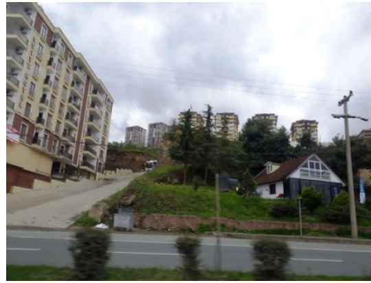
Figure II-19: Habitat collectif en Turquie (Source : Auteur, 20/04/ 2019 à 9 h.)
