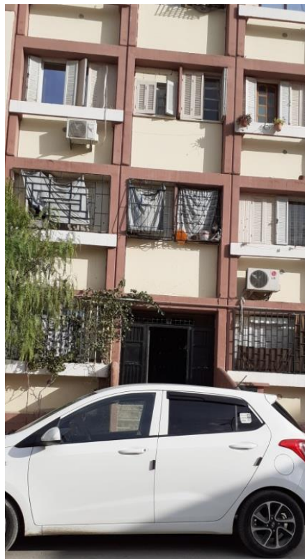
Figure V-96 : vue des logements occupés par les habitants (Source : Auteur, 2019)
