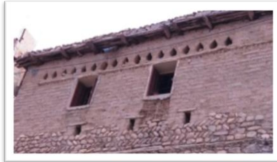
Figure V-4 : Forme des fenêtres( triangulaires et rectangulaires ) (Source : Auteur, 2016)
