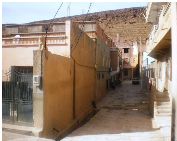
Construction des avaloirs
