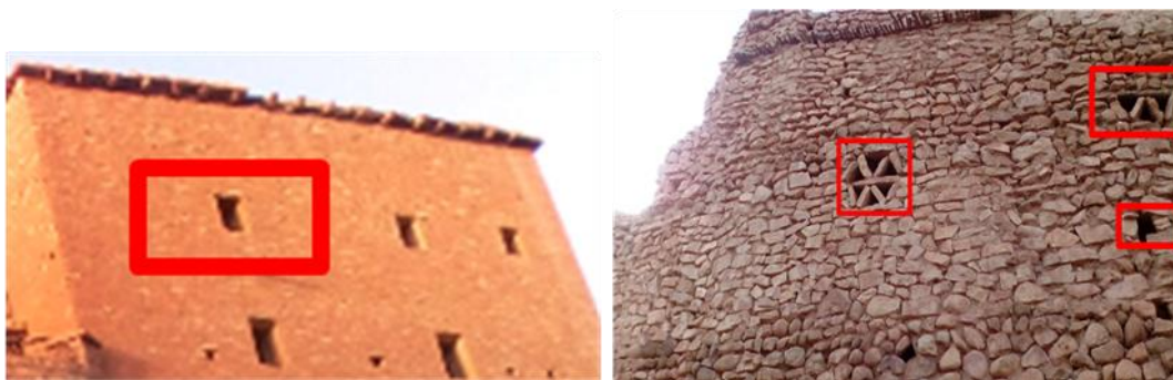
Figure V-50 : Forme des fenêtres (triangulaires et rectangulaires) (Source : Auteur, 2016)
