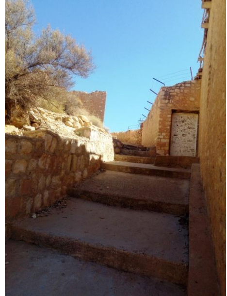
Figure V-67 : Revêtement de la rue par le béton et le pavage en pierre (Source : Auteur, 2018)
