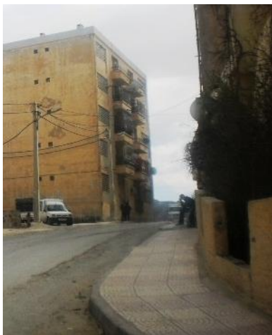
Realisation des trottoirs
