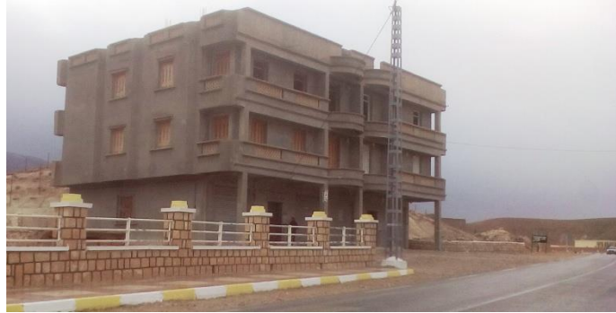
Figure V- 69 : locaux commerciaux le long de la RN31 (Source : Auteur, 2017)
