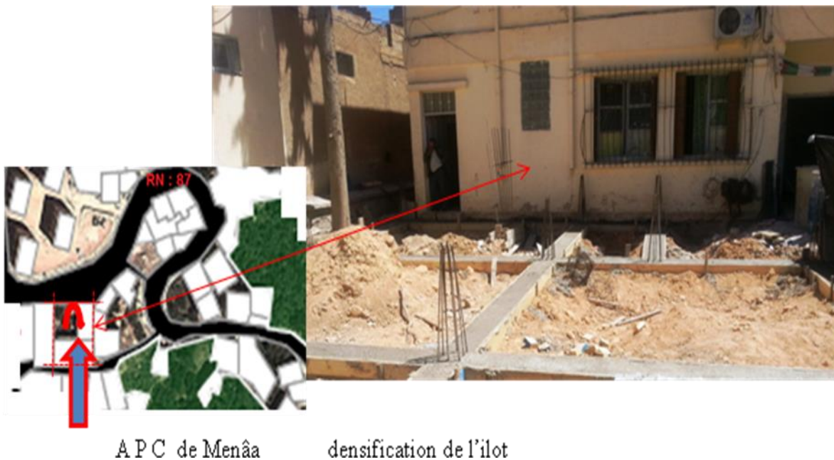
Figure V-45 : Densification d'une partie du bâti à l'intérieur de l'ilot APC de Menâa (Source : Auteur, 2015)
