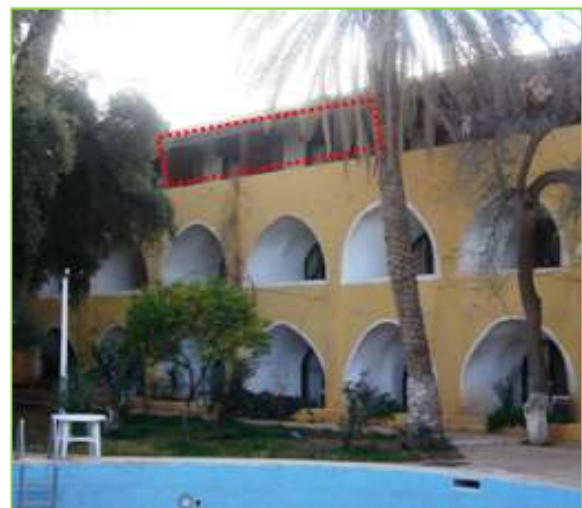
Figure III.16: Les loggias des chambres [Auteur]
