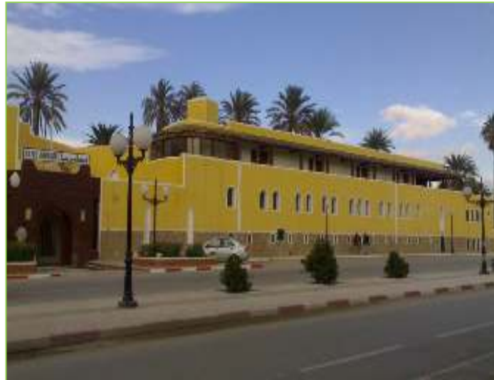
Figure III.14: Façade de l'hôtel sur la rue. [Auteur]
