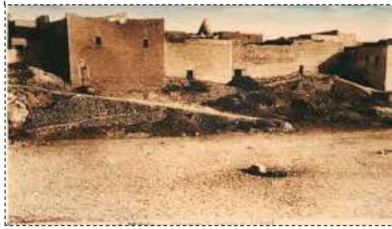
الصورة رقم 02: واجهة لمجموعة مساكن حي الشتاوة
