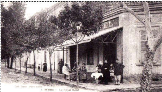
الصورة رقم 24: ترانصيف البنايات على طول الشارع
