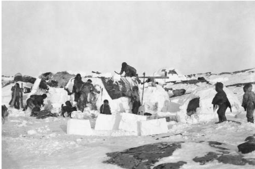
صورة 11.1: عملية صناعة اللبنات الثلجية عند الاسكيمو المصدر: https://www.reddit.com/inuit_people_building_an_igloo
