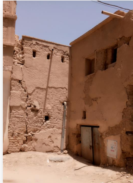
صورة 27.4 : صورة تبين الواجهات الصماء و مواد البناء المستعملة المصدر: الباحثة 2016
