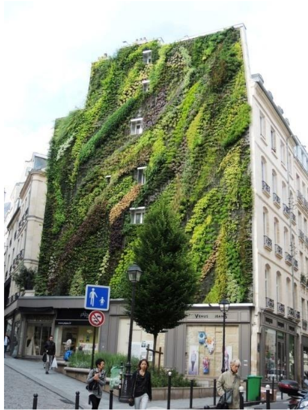
Figure III-19 :Exemple de réalisation de mur végétal rue d'Aboukir à Paris (Patrick Blanc.2003)
