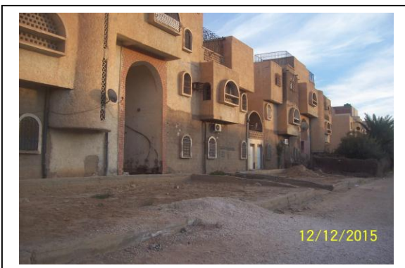
120 logements DNC ZHUN Ouest
