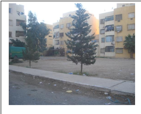
208 logements Belaïat ZHUN Ouest
