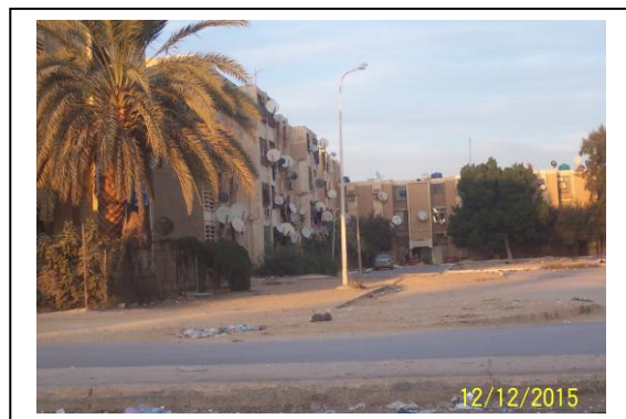
1000 logements ZHUN Ouest
