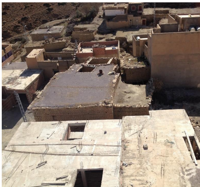
FIGURE 9: PHOTO MONTRANT UN TRAITEMENT DE TERRASSE AVEC L'ARGILE DE TIGHARGHAR ; SOURCE : AUTEUR.
