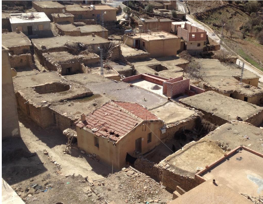
FIGURE 1 : CETTE PHOTO ILLUSTRE LE TYPE DE MUTATIONS QUI SE SONT PRODUITES APRES LES CHANGEMENT D'ORDRE SOCIO-ECONOMIQUE ET L'AVENEMENT DES NOUVEAUX MATERIAUX DE CONSTRUCTION, LA MAISON AVEC UNE TOITURE INCLINEE EST PARTICULIERMENT INEDITE DANS LES AURES, PUISQUE, EN GENERAL LES TOITURES SONT PLATES ; VILLAGE DE THNIET EL-ABEDSOURCE : AUTEUR.
