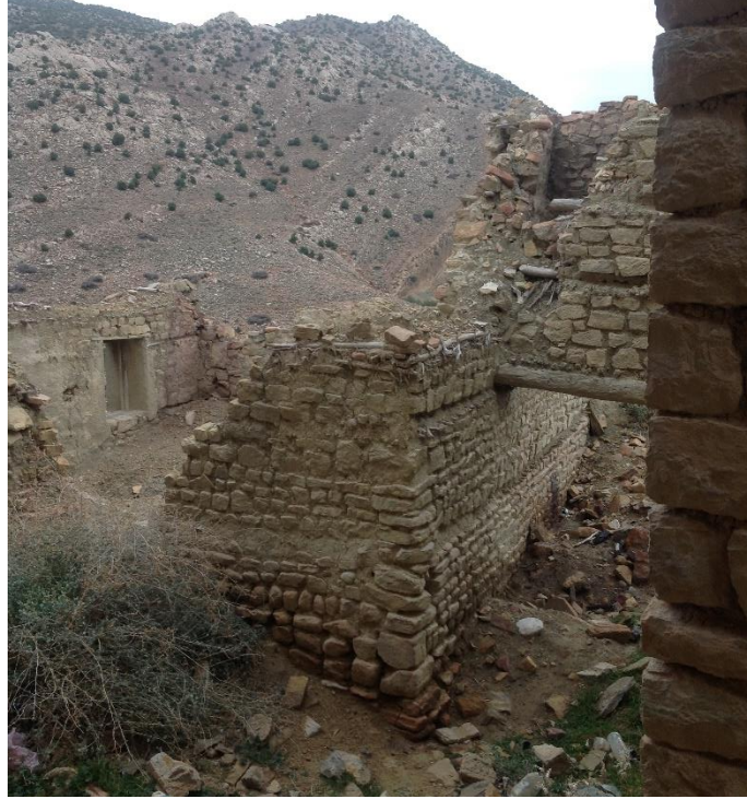
FIGURE 20: IMAGE MONTRANT L'ETAT DES MAISONS DELABREES, AINSI QUE LE RESTE D'UN PASSAGE COUVERT ; SOURCE : AUTEUR.
