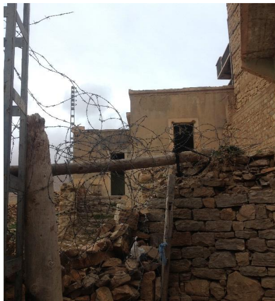
FIGURE 18: IMAGE MONTRANT UNE RUE OBSTRUEE PAR DU FIL BARBELE ; SOURCE : AUTEUR.
