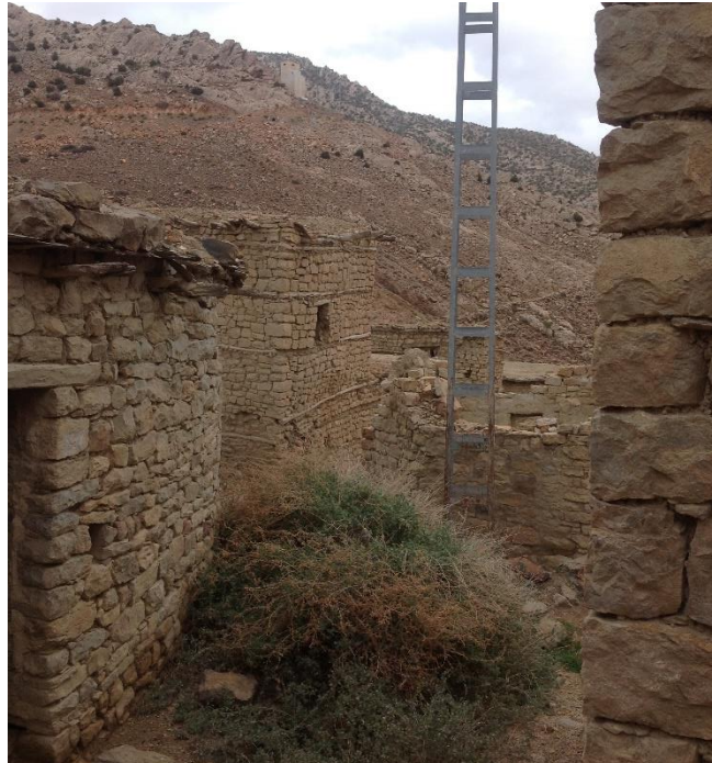
FIGURE 19: IMAGE MONTRANT UN POTEAU ELECTRIQUE A L'INTERIEUR DU VILLAGE ; SOURCE : AUTEUR.
