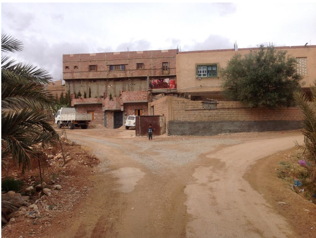
FIGURE 31: IMAGE MONTRANT L'ACCES PRINCIPAL DU VILLAGE D'EL-KOUDIA, LES CONSTRUCTIONS SONT TOUTES ENMMATERIAUX NOUVEAUX ; SOURCE : AUTEUR.
