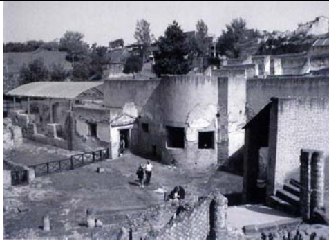
Fig. n°224, Fenêtres des thermes suburbains de Pompei, (Yegül, 2010, p57)
