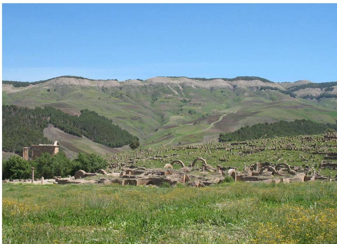
Fig. n°292, Les Grands thermes Sud de Djemila, partie Est, état actuel
