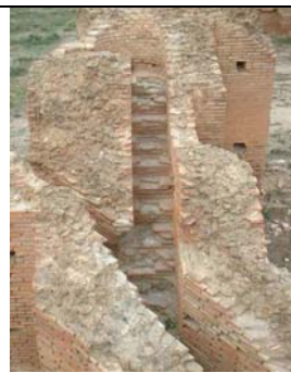
Fig. n°239 b, Escaliers Ouest, encastrés dans les murs Est et Ouest du grand frigidarium des Grands thermes Nord de Timgad
