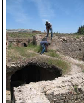
Fig. n°160 Destruction des terrasses des Grands thermes Sud de Djemila
