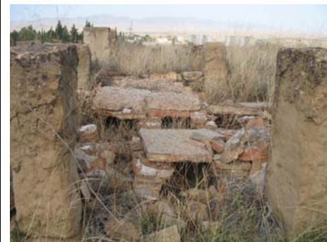
Fig. n°157, Hypocaustes de thermes du camp de Lambèse
