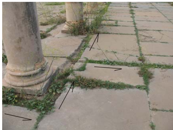
Fig. n°106, Portiques du forum de Timgad, pavement retaillé pour recevoir les conduites d'eau en plomb
