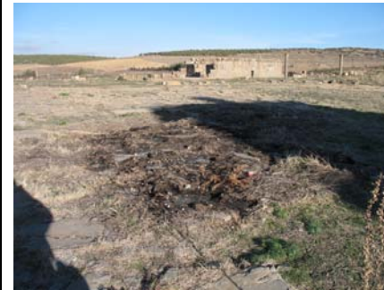
Fig. n°164, Destruction du pavement par le feu
