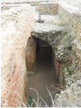
Fig. n°220, Ouverture des galeries de chauffe (indiquée par une flèche noire) aux Grands thermes Sud de Timgad
