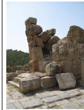
Fig. n°165, Basculement des pierres de la porte
