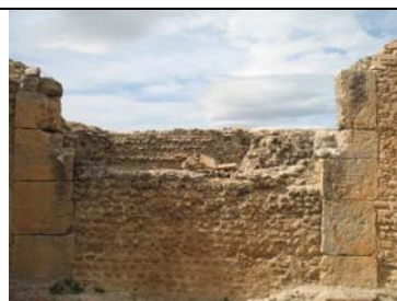
Fig. n°237, Grande fenêtre du caldarium des Grands thermes Sud de Djemila
