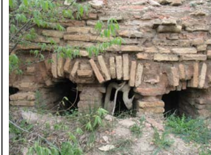
Fig. n°158, Dégradation des hypocaustes des thermes du camp de Lambèse
