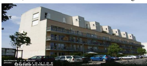
Figure III-45 : Vue extérieure sur le quartier Selvierra. ( http://www.reseau-breton-batiment-durable.fr )
