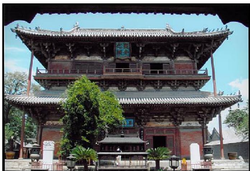
Figure 1.12 :Savoir-faire liés à l'architecture traditionnelle chinoise pour les structures à ossature en bois (Source : UNESCO.org.fr « Culture, Patrimoine immatériel », 2015)
