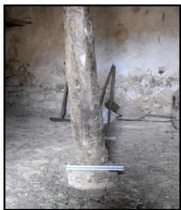
Figures 4.51, 4.52: Piliers posés sur des pierres au sol. A gauche : maison des Belaieche à Hiza, à droite: maison des Bekhouche à Haourireth (Source : Auteur, 2015)
