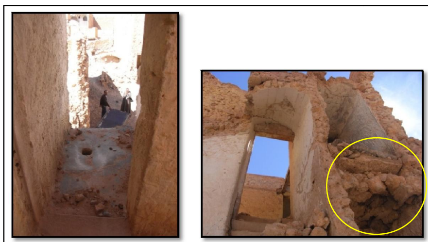
Figures 5.53: Latrine et vide sanitaire. Ksar de N'goussa. (Source : Auteur, 2015)
