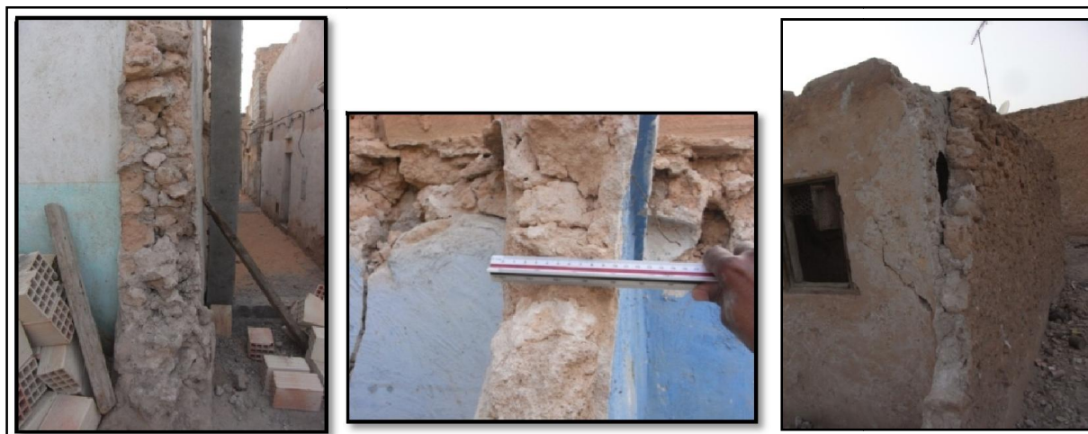
Figures 5.19 : Mur extérieur au RDC et murs d'étage, Maisons dégradées au ksar de Ouargla) (Source : Auteur, 2015)
