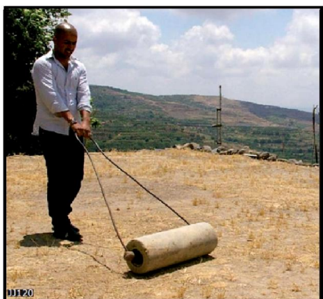
Figure 4.84 : Méthode actuelle de compactage et d'entretien de terrasse traditionnelle (exemple de la Jordanie). (Source : Jäger, 2012)
