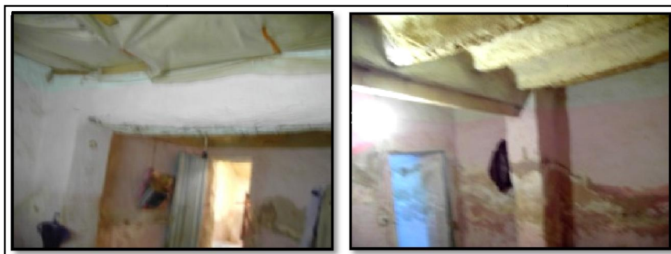
Figures 5.25: Structure intermédiaire en portique. Maison faisant partie du projet 150 logements à réhabiliter au ksar de Ouargla. (Source : OGEBC Ouargla, 2013)
