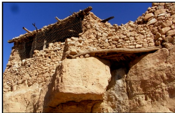
Figure 4.28 : Système de soutien des fondations par des appuis horizontaux en bois. Maison à Haourireth. (Source : Auteur, 2015)
