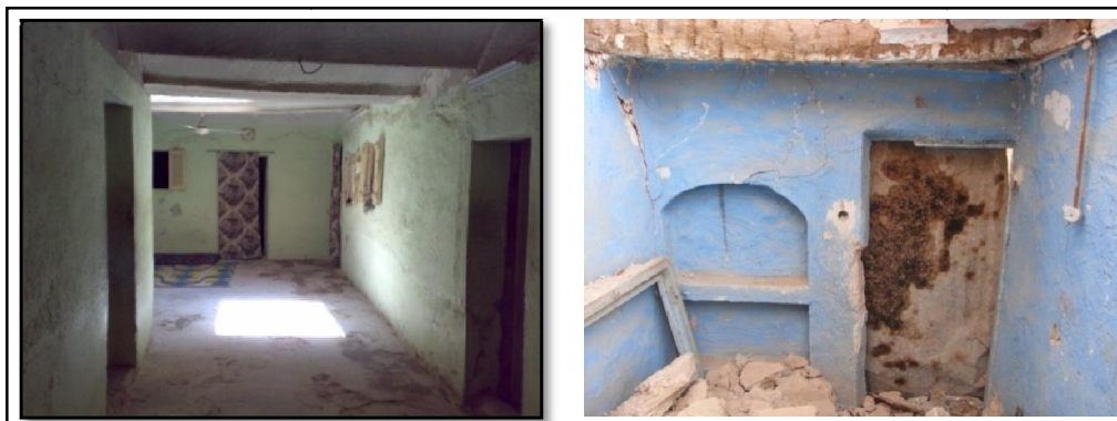
Figures 5.40, 5.41: Revêtement de murs intérieurs et peinture. Maisons au Ksar de Ouargla. (Source : à gauche : OGEBC, 2013, à droite : Auteur, 2015)
