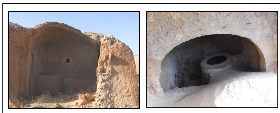
Figures 3.53, 3.54: « Khabia » dans une maison rurale à Guemar et Moui-Bahi (Source : Auteur, 2015)
