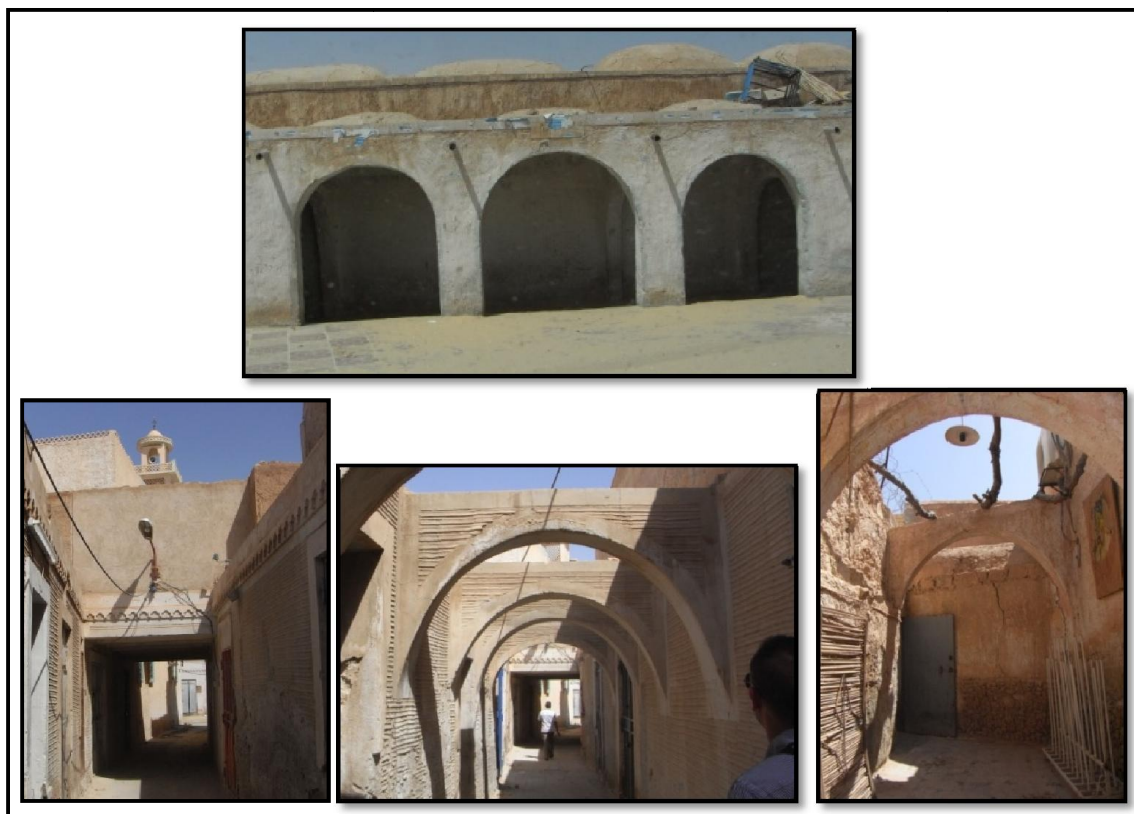
Figures 6.57: Sabat (Guemar), passage couvert et encorbellements (Laacheche). (Source : Auteur, 2015)
