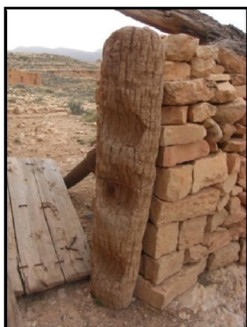
Figure 4.97: Escalier sculpté dans un tronc de palmier (récupéré). Maison des Belaieche à Hiza. (Source : Auteur, 2015)
