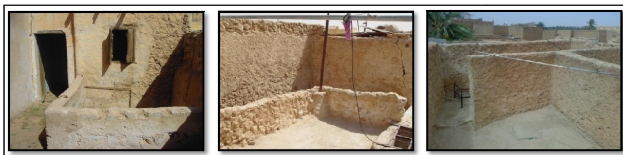
Figures 5.37 Traitement de terrasses muret et revêtement. Maisons au ksar de Ouargla. (Source : OGEBC Ouargla, 2013)
