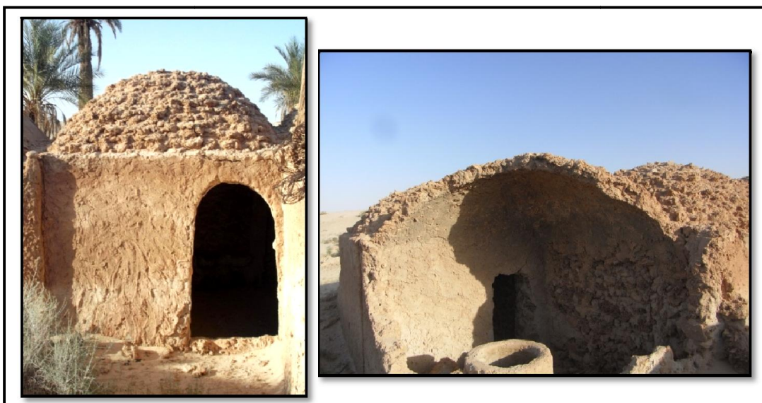
Figures 6.25 : Forme, texture et coupe d'un plancher à coupole. Maison rurale à Lebdoou,Guemar (Source : Auteur, 2015)
