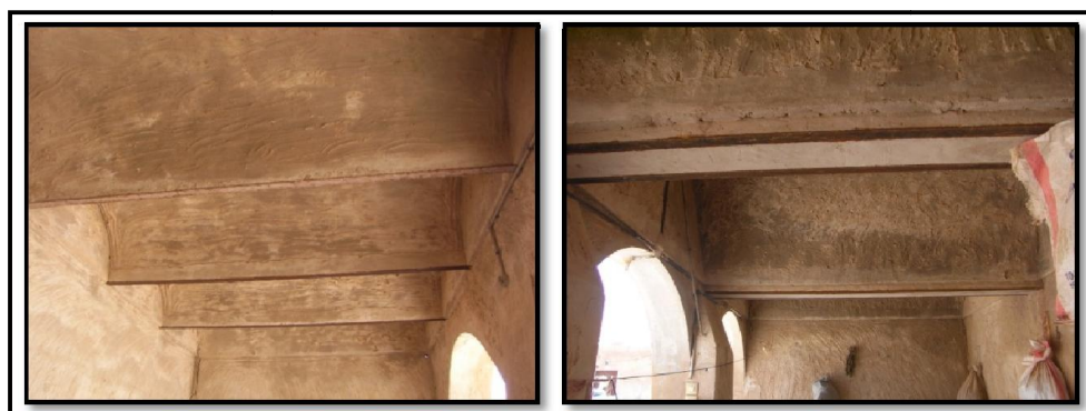
Figures 6.30, 6.31: Juxtaposition de plusieurs « demsa » dans un même espace (Sabat), avec solive métallique simple et double. Deux Maisons villageoises à Nezla de Guemar. (Source : Auteur, 2015)
