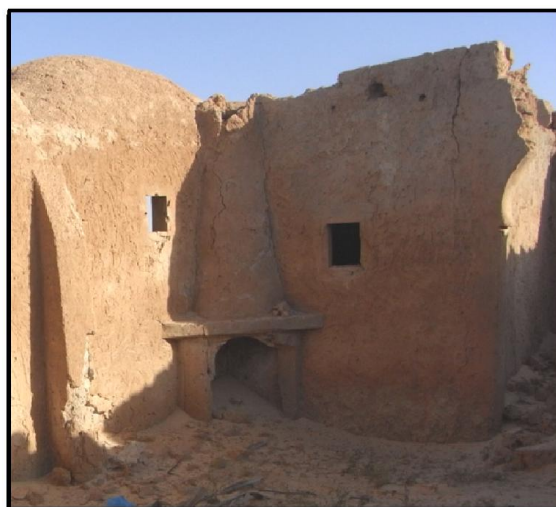
Figure 6.54: Cheminée dans une cour. Maison à Lebdoe. (Source : Auteur, 2015)
