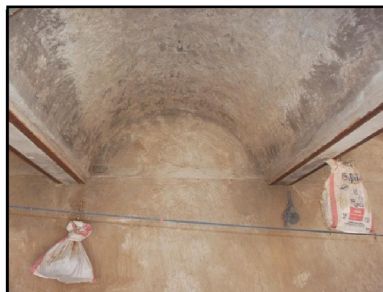
Figure 6.36: Revêtement intérieur voute avec fer à T et mur. Maison villageoise, Nezla de Guemar. (Source : Auteur, 2015)
