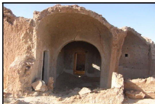
Figure 6.22 : Arcade de séparation entre espaces et soutenant le plancher (gouba) Maison rurale à Lebdoe, Guemar. (Source : Auteur, 2015)
