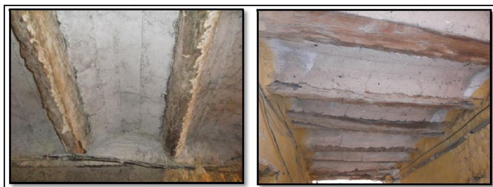
Figures 5.29: Exemple de plancher à voutains et solives en troncs de palmier. ksar de Ouargla. (Source : Auteur, 2015)
