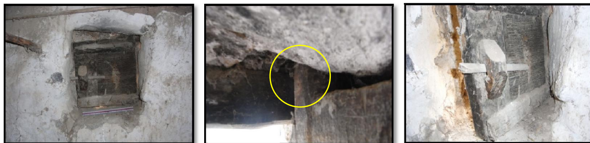
Figures 4.94: Battant de fenêtre, pivot et système de fermeture (pêne: tige et gâche: trou dans le mur). Maison semi troglodyte à Hiza (Source : Auteur, 2015)
