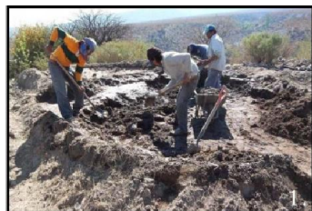
Figure 1.17: Préparation et confection de l'adobe pour la construction.. (Source : Boissard et al, 2008, p .9)
