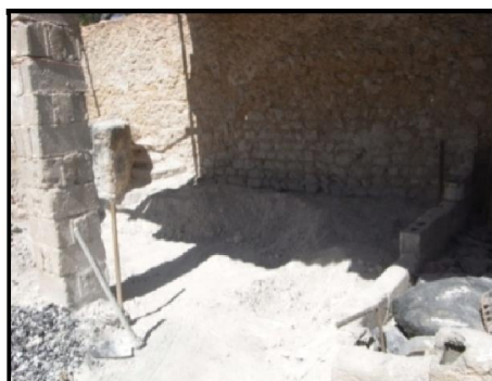
Figure 5.12 : coin de stockage du produit (Source : Auteur, 2014)
