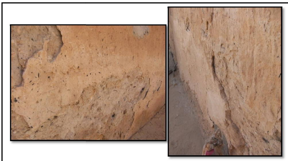
Figures 6.38: Revêtement de mur extérieur. Maison villageoise, Nezla de Guemar. (Source : Auteur, 2015)
