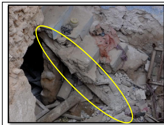
Figure 5.50: Structure apparente d'escalier sur paillasse en bois. Ksar de Ouargla. (Source : Auteur, 2015)
