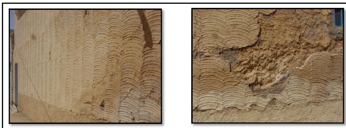
Figures 6.39 : Revêtement de murs extérieurs à la taloche (panneau de mur et détail enduit sur revêtement ancien). Quartier Laacheche, El Oued. (Source : Auteur, 2015)
