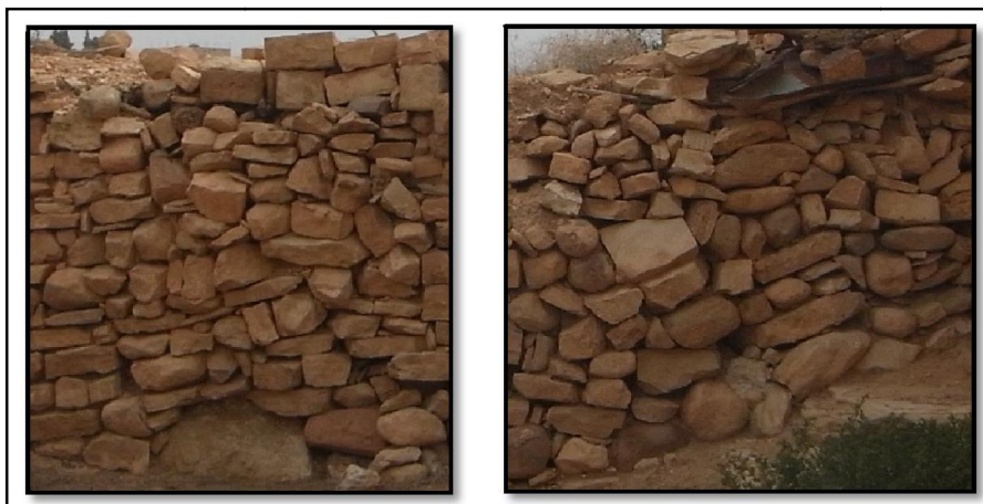
Figures 4.2 : Pierres de diverses formes et dimensions utilisées dans la construction (Source : Auteur, 2015)
