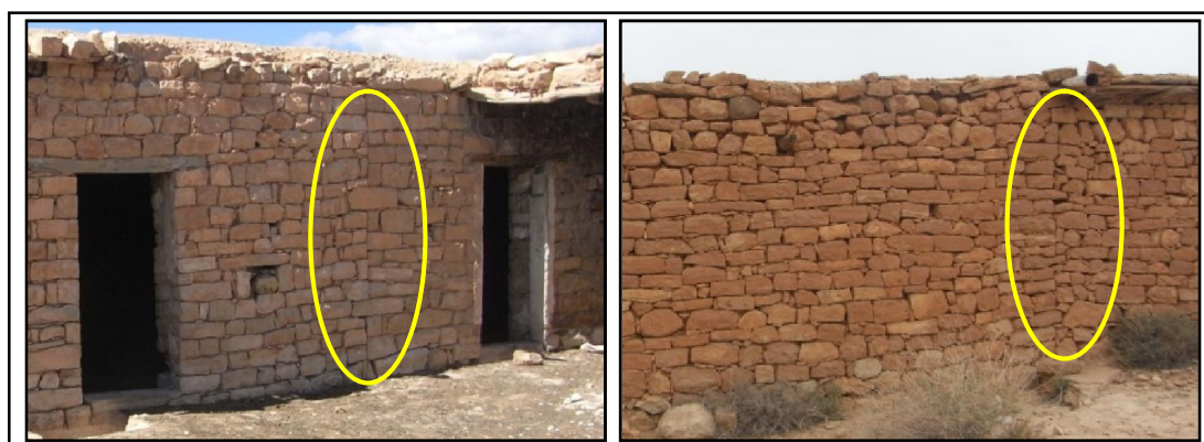
Figures 4.45, 4.46: Prolongement de mur ( cherka ). A gauche : maison à Tahamemt, à droite : maison des Belaieche à Hiza . (Source : Auteur, 2015)
