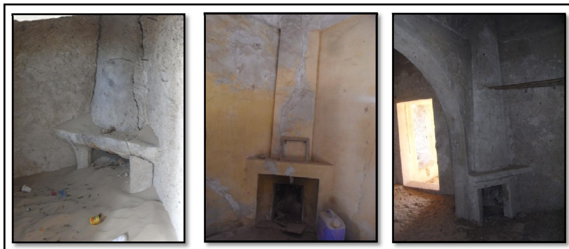
Figures 6.53: Différentes formes que prend la cheminée. (Source : Auteur, 2015)
