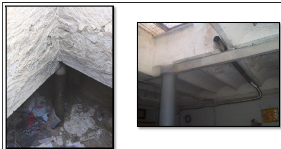
Figures 5.27, 5.28: Structure intermédiaire à solives en métal sous patio. Maisons au ksar de Ouargla. (Source : à gauche: Auteur, 2015, à droite: OGEBC Ouargla, 2013)
