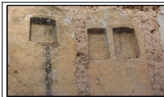
Figure 5.55: Exemple de niches aux murs intérieurs. Ksar de Ouargla. (Source : Auteur, 2015)
