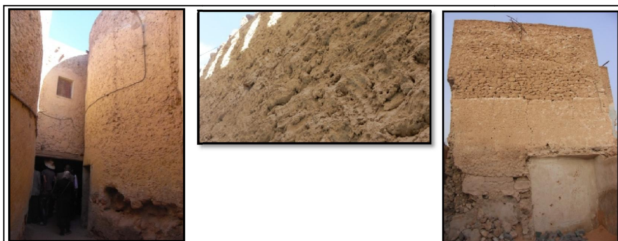
Figures 5.39: Revêtement de murs extérieurs au timchemt. Ksar de Ouargla. (Source : Auteur, 2015)
