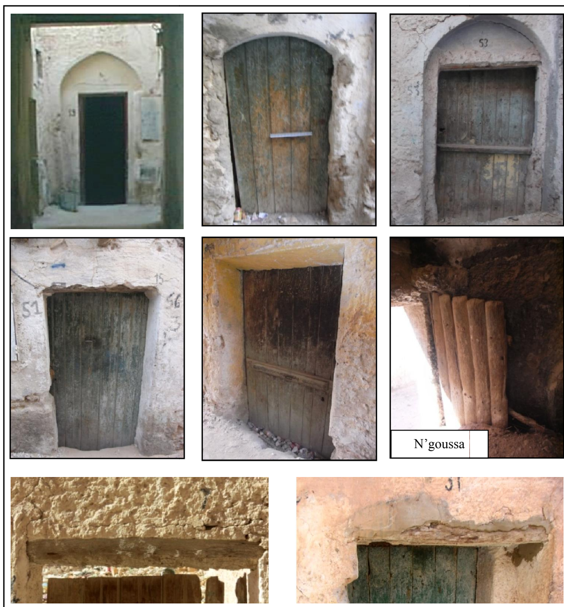
Figures 5.43 : Typologie de portes d'entrée et linteaux en tronc de palmier. Ksar de Ouargla et N'goussa (Source : Auteur, 2015)
