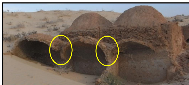
Figure 6.32: Jonction entre coupole et mur. Maison rurale à Moui Bahi, Kouinine (Source : Auteur, 2015)
