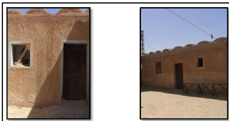
Figures 6.47: Exemples de fenêtres. Maison villageoise (Source : Auteur, 2015)
