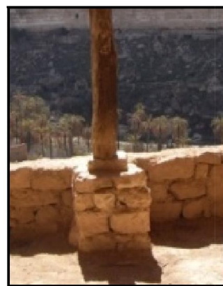
Figures 4.51, 4.52: Piliers posés sur des pierres au sol. A gauche : maison des Belaieche à Hiza, à droite: maison des Bekhouche à Haourireth (Source : Auteur, 2015)
