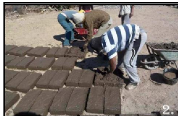
Figure 1.17: Préparation et confection de l'adobe pour la construction.. (Source : Boissard et al, 2008, p .9)
