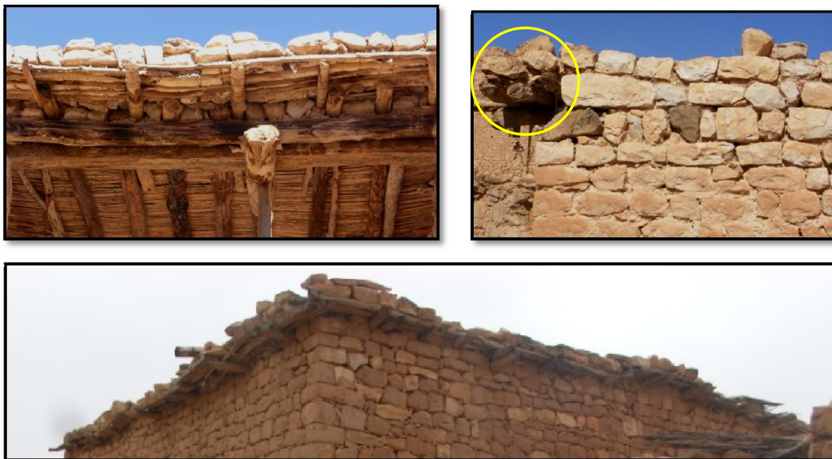
Figures 4.81, 4.82, 4.83: Protection périphérique de plancher terrasse. En haut: maisons à Haourireth, en bas : maison à Hiza. (Source : Auteur, 2015)
