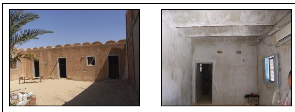
Figures 3.55, 3.56: Chambres donnant sur cour et intérieur d'une chambre (Source : Auteur, 2015)
