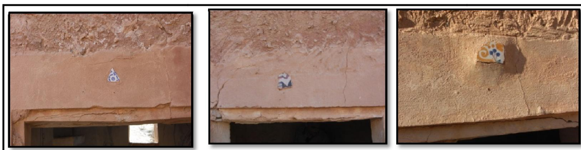
Figures 6.59: Morceaux de faïence en haut de portes sur cour. Maison rurale à Lebdoue, Guemar. (Source : Auteur, 2015)
