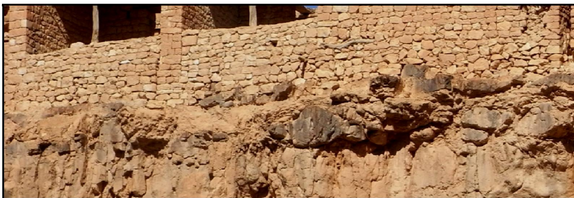
Figure 4.26: Massif rocheux utilisé comme fondations pour maison à Haourireth. (Source : Auteur, 2015)
