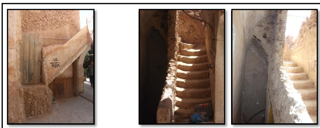
Figures 6.48: Type d'escaliers à structure en pierre hourdée. Agauche : maison à Laacheche transformée en cafet., à droite : maison villageoise à Nezla de Guemar. (Source : Auteur, 2015)
