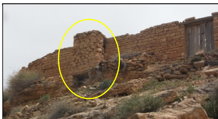
Figure 3.18: Vue extérieure de hafrakth Maison de la famille Belaieche à Hiza (Source : Auteur, 2015)
