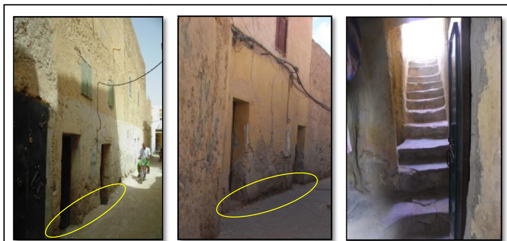
Figures 3.27, 3.28, 3.29: Entrées de maison, seuil et escalier menant de la rue à lā'lli (Source : Auteur, 2013)
