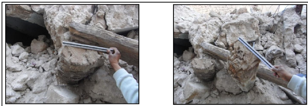
Figures 5.16 : Sections de troncs de palmier, solives dans la construction, ksar de Ouargla. (Source : Auteur, 2015)
