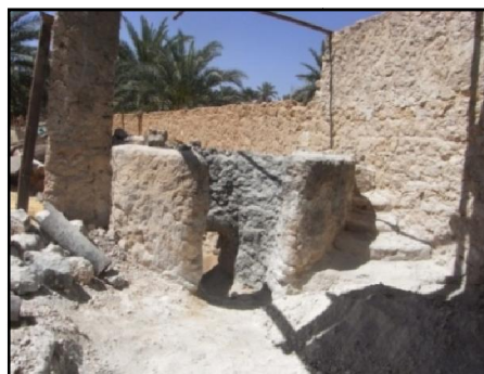
Figure 5.9 : Four construit en pierre (Source : Auteur, 2014)
