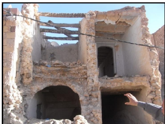
Figures 5.18 : Murs d'élévation et structure de planchers, Maison dégradée au ksar de Ouargla) (Source : Auteur, 2013)
