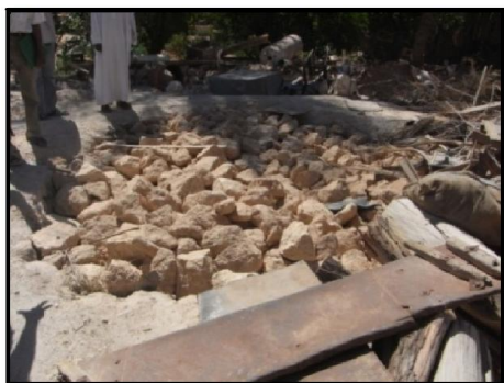
Figure 5.8 : Four sous forme de fosse chargée de pierres à timchemt (Source : Auteur, 2014)
