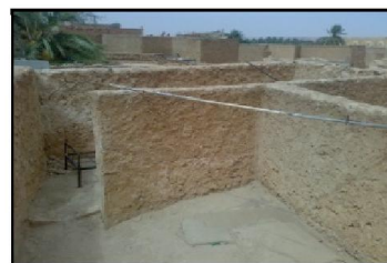
Figures 3.34, 3.35 : Haut du trou d' āmmisiddār et parapet ou mur de protection de la terrasse Source : OGEBC Ouargla (2013)
