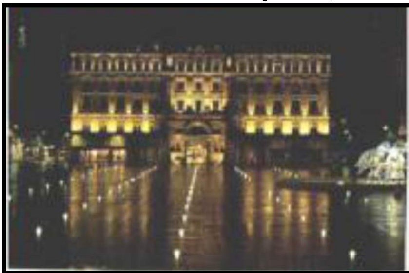
Figure II-14 : éclairage nocturne de la place de la place des Terreaux en France. Source : Roger Narboni, 1995
