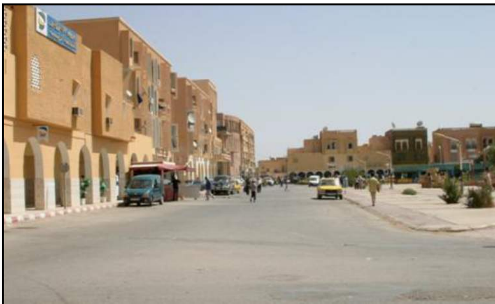
Figure X-7 : Photographie récente désignant les parois de la place, source Autrice
