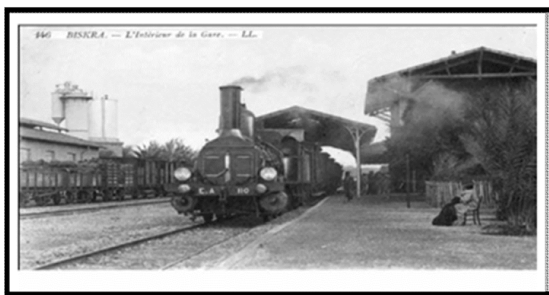
Figure 26 : L'intérieur de la gare ferroviaire de Biskra.
