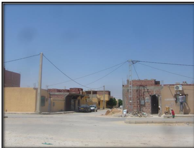
Photo n°5.11 : Modifications au niveau d'un type d'habitat planifié Source : auteur, avril 2012
