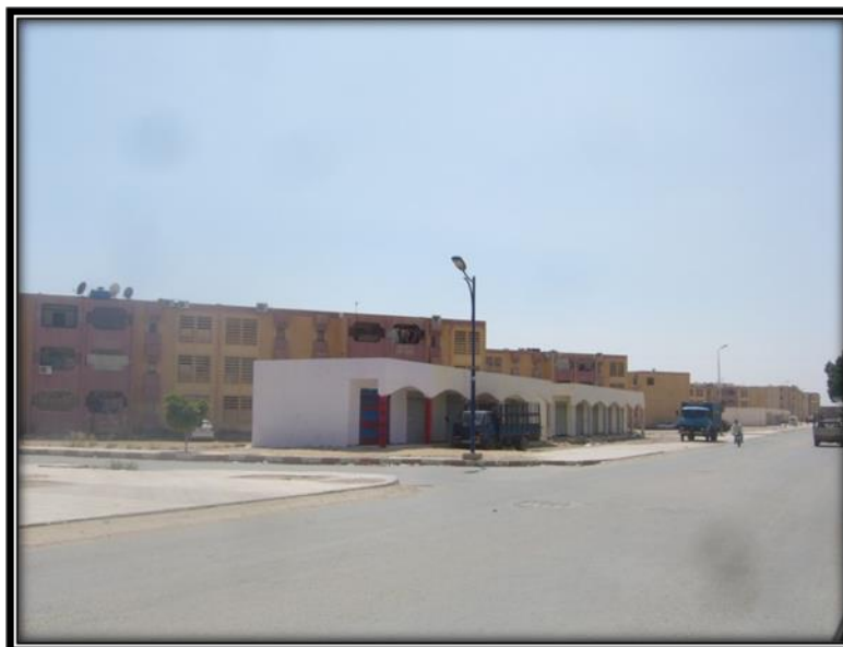
Photo n°5.12 : un quartier de la ZHUN de Tolga. Source : auteur, 2012
