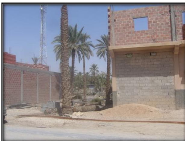
Photo n° 4.08 : substitution des palmiers en bordure de route par le bâti, Tolga
