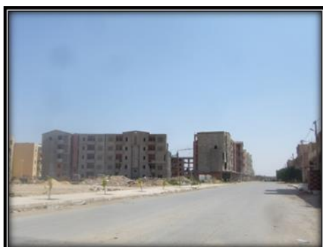
Photo n°5.14 : construction en Cours d'immeubles d'habitation, ZHUN de Tolga. Source : auteur, 2012
