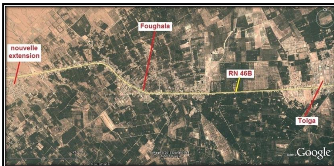
Figure n° 4.14 : Extension sur la RN 46 entre Tolga et Foughala. Source : auteur, fond d'image Google Earth
