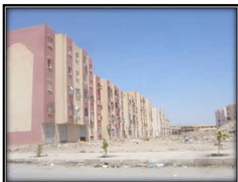
Photo n°5.13 : alignement de bâtiments en barre, ZHUN de Tolga. Source : auteur, 2012
