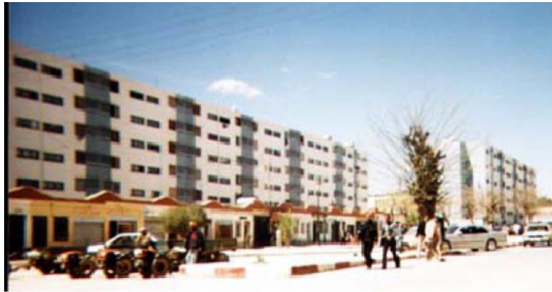
Fig. IV.12: La cité HLM au niveau du centre ville, un type d'habitat collectif colonial.
