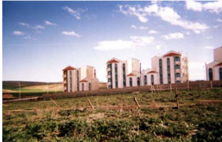
Fig. IV.14 : Au niveau du carrefour de la voie d'évitement avec la RN 88 menant à Ain Touila de nouveaux programmes d'habitat viennent gonfler la taille de la ville.
