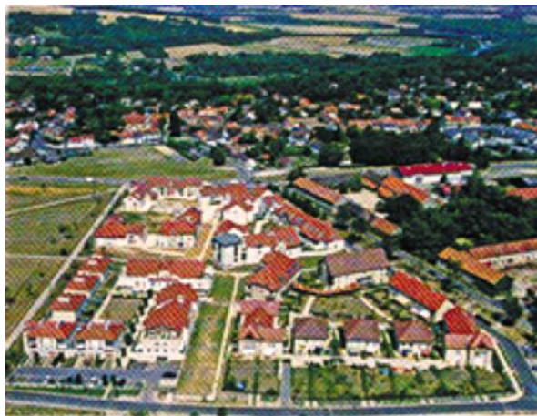
Fig. II.1 Localisation de maison Individuelle à la périphérie
