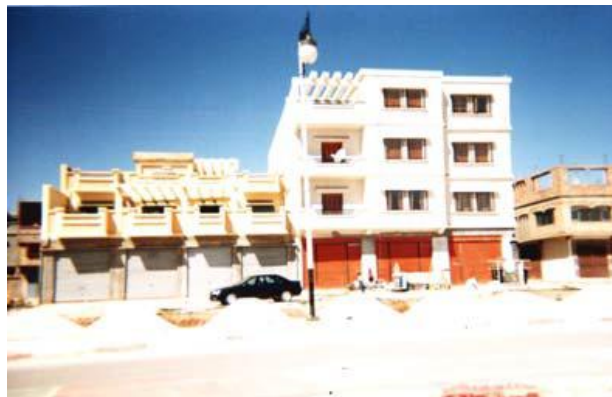
Fig. IV.10 : Les lotissements au niveau de chef lieu de Wilaya, Une hétérogénéité des façades et des niveaux.
