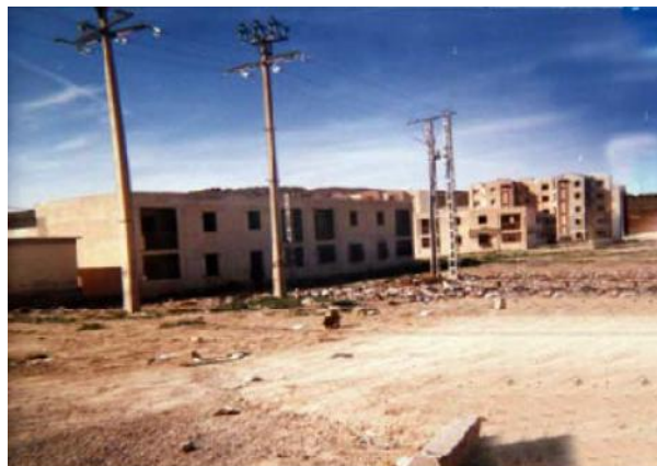
Fig. IV.11: Le programme de logements évolutif au niveau du quartier Moussa Reddah, en R+1, Un programme en état de dégradation avancé avant même son occupation.
