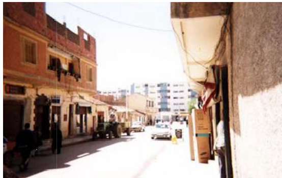
Fig. IV.4 : Le noyau colonial de Khenchela; Les opérations de rénovation et de sur-élévation ponctuelles Continuent de porter de graves atteintes au patrimoine historique et architectural.
