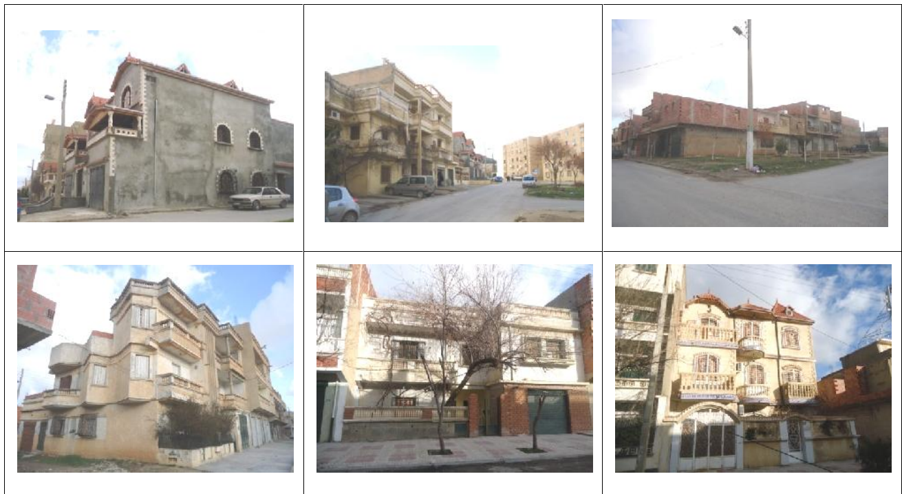
Fig. V.4: les façades « Elaboré par l'auteur 2011 »
