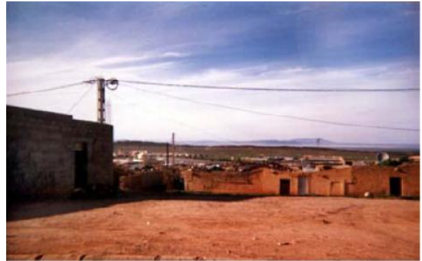
Fig. IV.5 : Cité de recasement Ennassim Connu sous le nom de CHABORD
