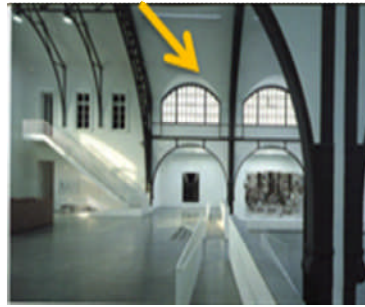
Baie située en haut
